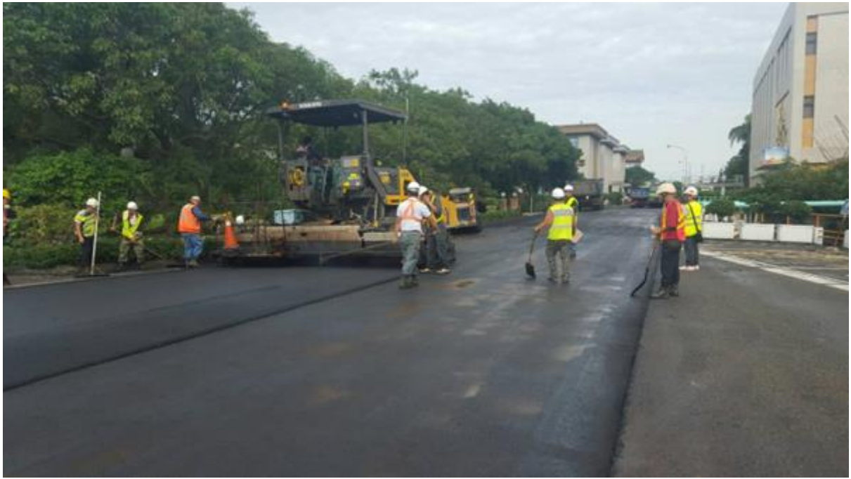
圖 2-34 路面鋪築
