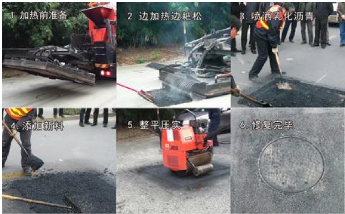
圖 2-37 公路鋪面修護新技術施工流程
