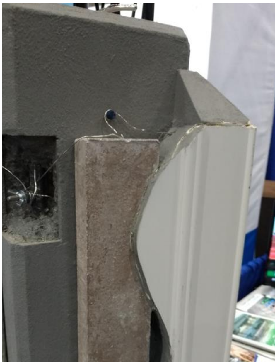
圖 2-25 Galvashield DAS Jacket 保護系統內部
