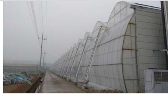
圖 17、實地訪視 Udemji 智慧農場，該溫室側邊採用雙層包覆，以強化溫室之節能效果
