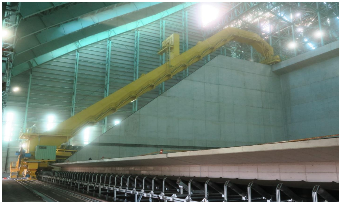
圖 52 韓國電廠煤倉內部照片
