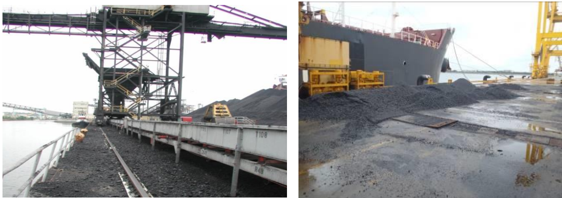
圖 10 抓斗式卸煤機易產生溢漏問題污染環境
