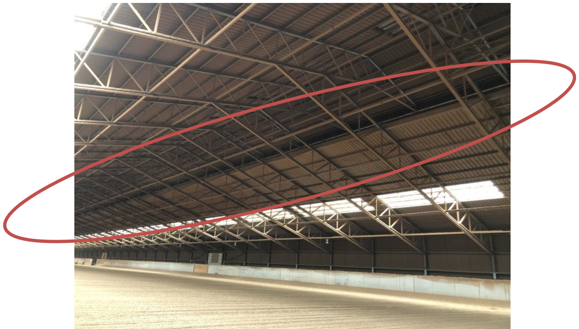
圖 73 開槽式的屋頂設計內部照片
