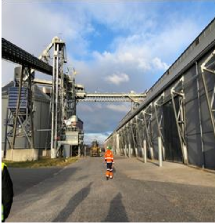
圖 39 全密閉式輸送系統
