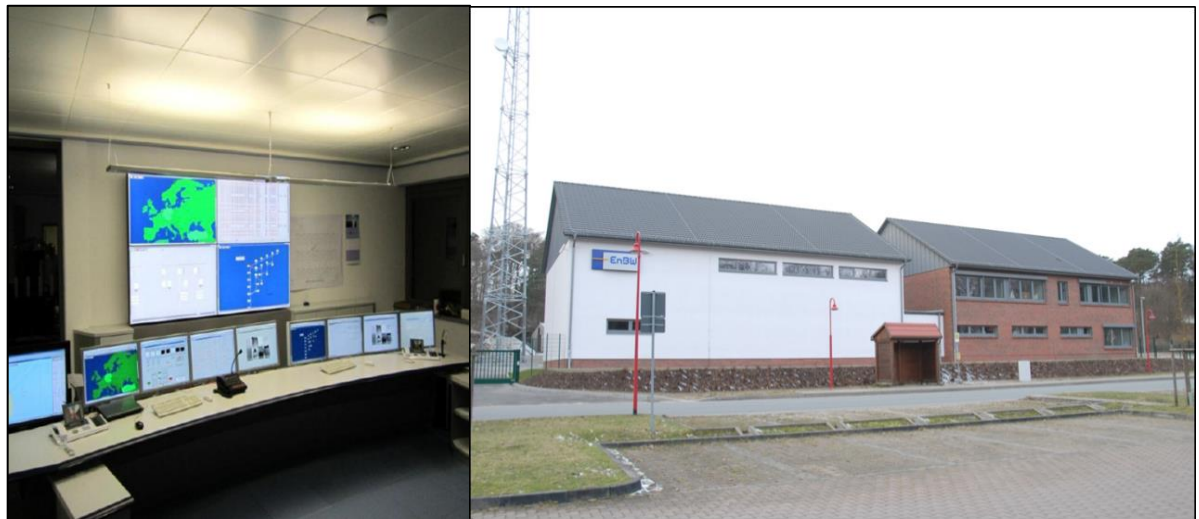
圖 5 EnBW 公司位於 Barhöft 的控制室與運維中心
