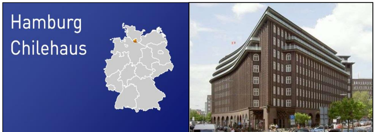
圖 2 EnBW 公司位於漢堡 Chilehaus 的離岸風力建置中心
