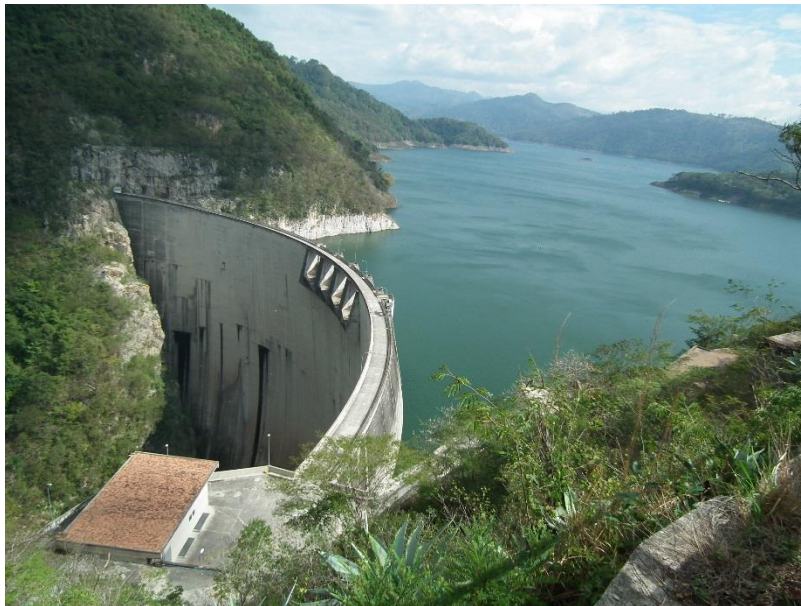
圖 40 EL Cajón 水壩之二
