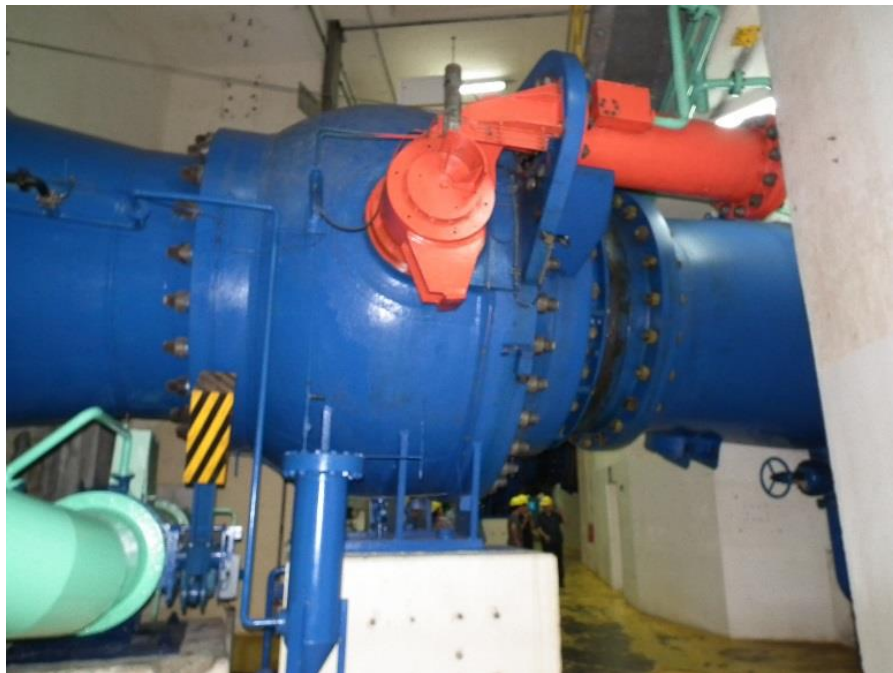
圖 42 EL CAJON (CJN)之水輪機控制閥(水由左側進入，右側為水輪機之水路入口)
