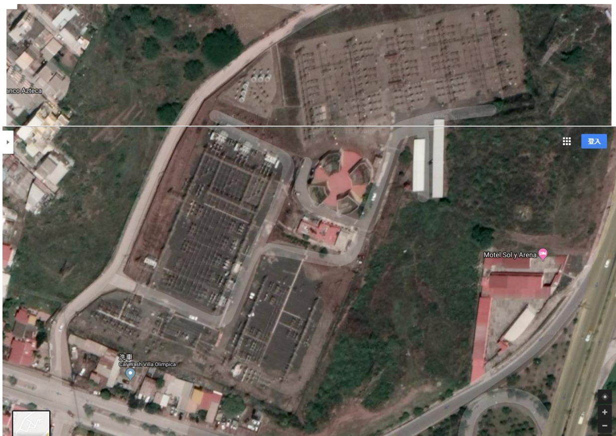
圖 6 SuYaPa (SUY)超高壓變電所空照圖
