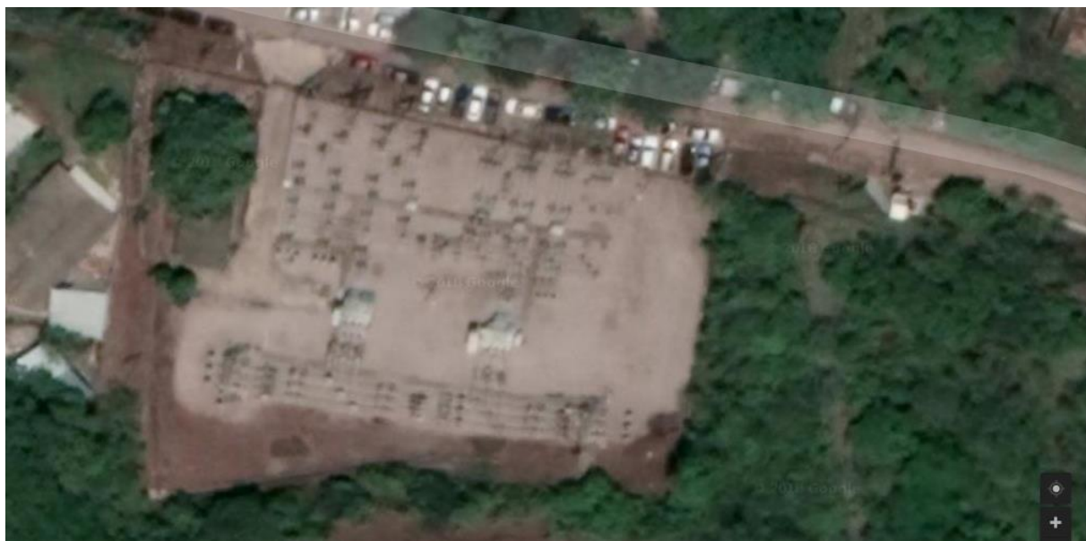
圖 22 LAINEZ (LNZ)配電變電所空照圖
