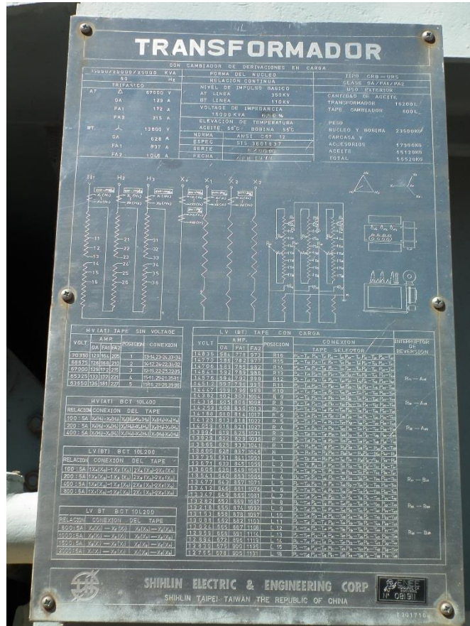
圖 26 變壓器之銘牌
