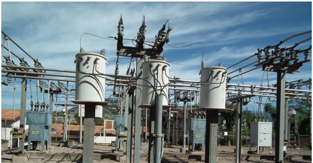
圖 28 22L61、22L62、22L63 及 22L64 等饋線斷路器
