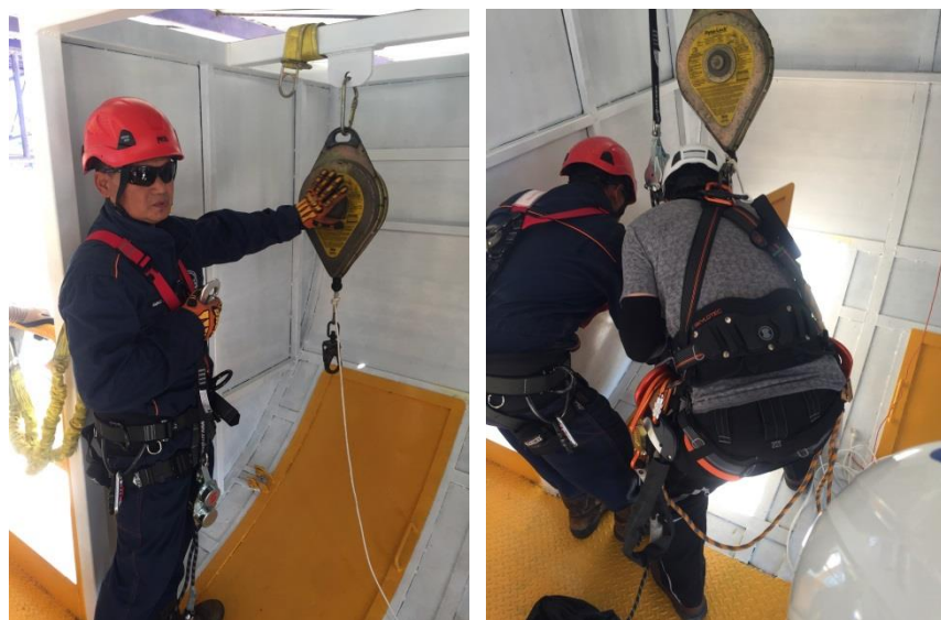
圖 4-1-12 SRL 防墜工具介紹(主要固定在背後)
