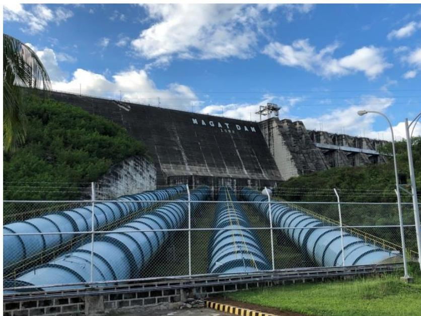
圖 16 MAGAT DAM 大壩及電廠壓力鋼管
