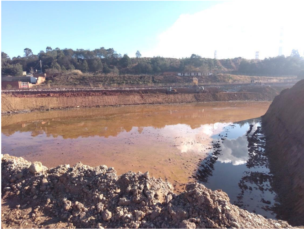
圖 7 原汞污染污泥、土壤暫存區及污染改善開挖基坑
