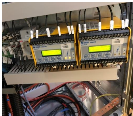
圖 4-16 磁場接地電驛
