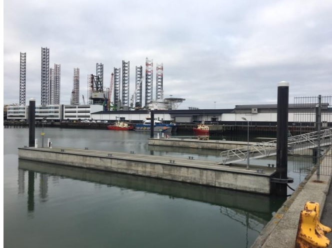
圖 32 Esbjerg 港運維基地 Orsted 建置之浮動碼頭
