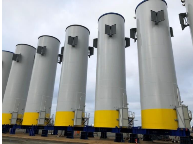
圖 29 Esbjerg 港塔筒站立區
