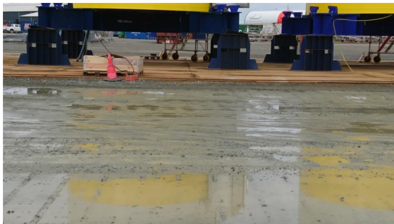
圖 31 Esbjerg 港塔筒堆儲區下方加鋪鋼板分散戴重
