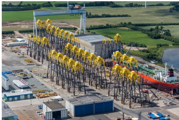
圖 6 Bladt Industries 於 Lindo 風電港水下基礎儲存區 (圖片源自 Bladt Industries 簡報)
