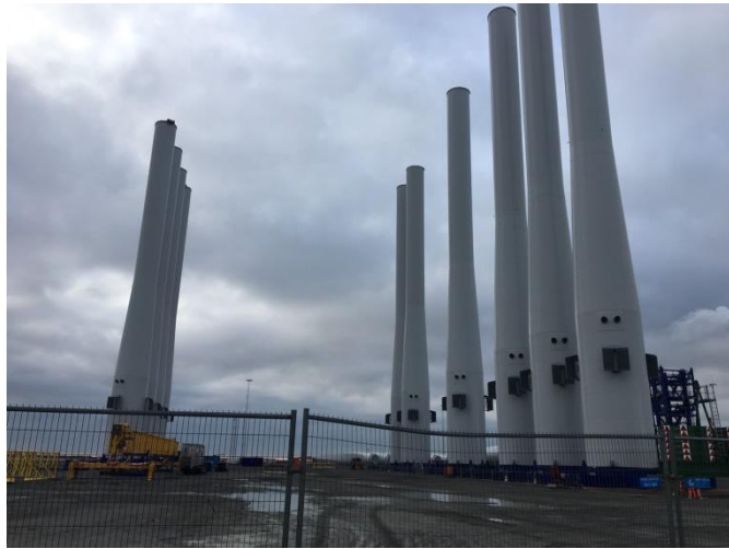
圖 30 Esbjerg 港塔筒預組裝基地
