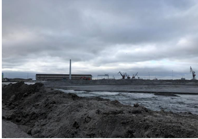
圖 10 Lindo 港填海造地工程
