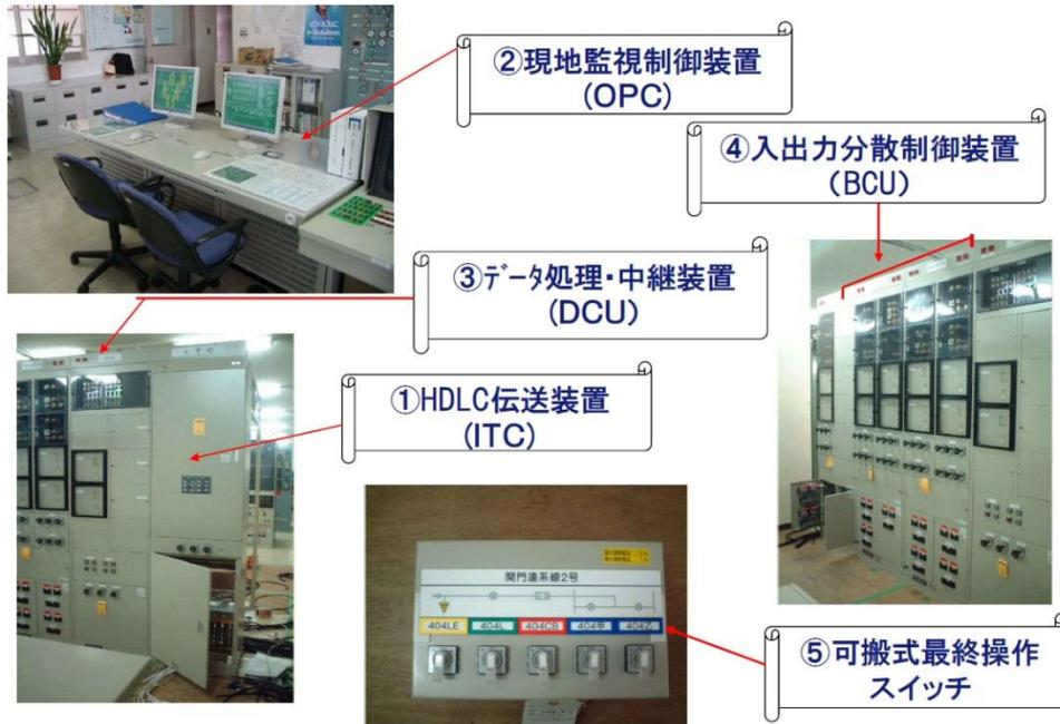
為了更進一步降低變電所監控系統成本，中電採納東芝公司 (Toshiba) 之提案，修改上述 DCS 架構，建置了新型的 DCS 架構，將 OPC 和 DCU 功能整合於可攜式個人電腦內，減少設置 OPC 及 DCU 之成本，其架構如下圖所示。目前中電 220kV 以下的變電所已開始導入新型的 DCS 架構，未來包含 500kV 變電所，也將逐步汰換為新型的 DCS 架構。
