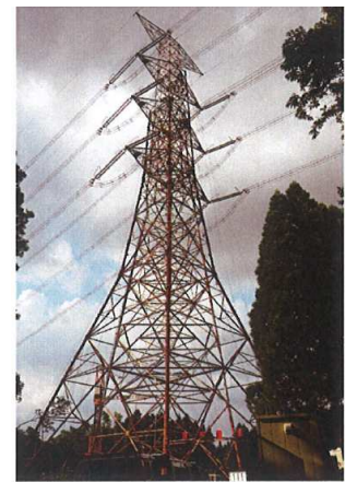
圖 3-11 受損鐵塔補強修復完成圖
