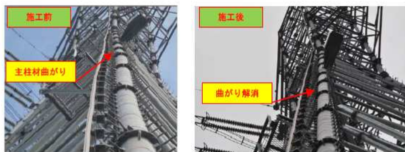
圖 3-16 鐵塔部材更換施工前後示意圖(JST 公司提供)
