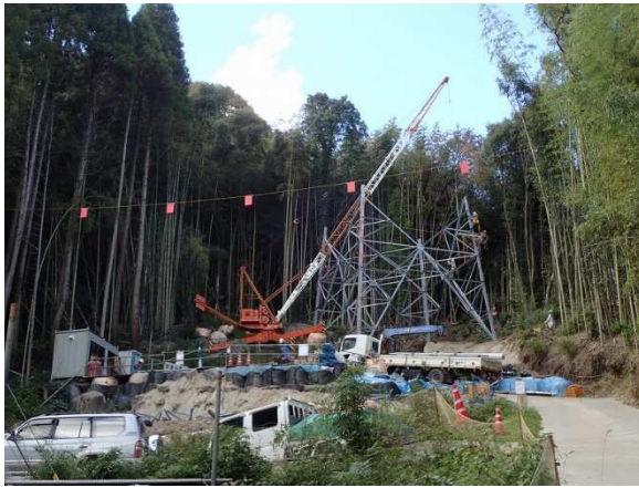
圖 3-20 本次實習現場—66kV 西大分篠原線工程新設 No.10 安裝示意圖
