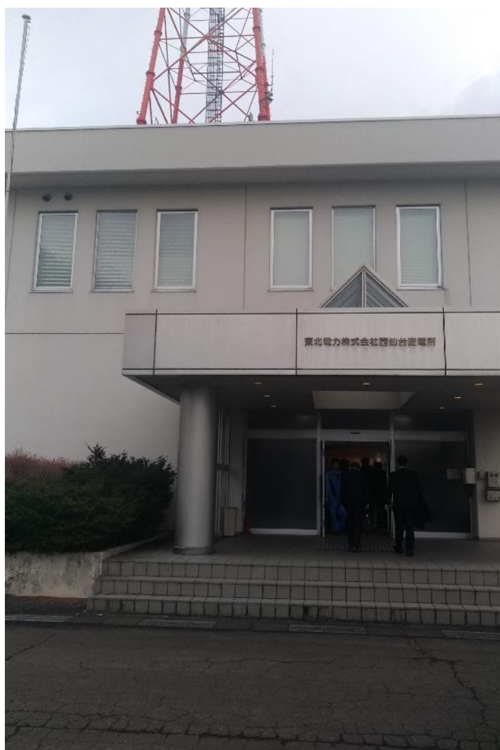
圖 3-5 東北電力公司西仙台變電所
