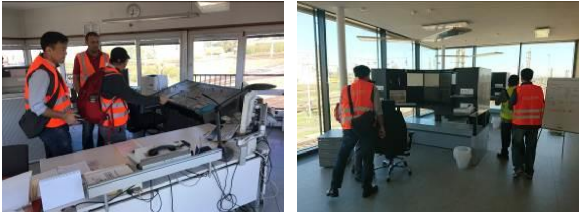
圖 5-4 既設之就地控制盤及新設之行車室設施
