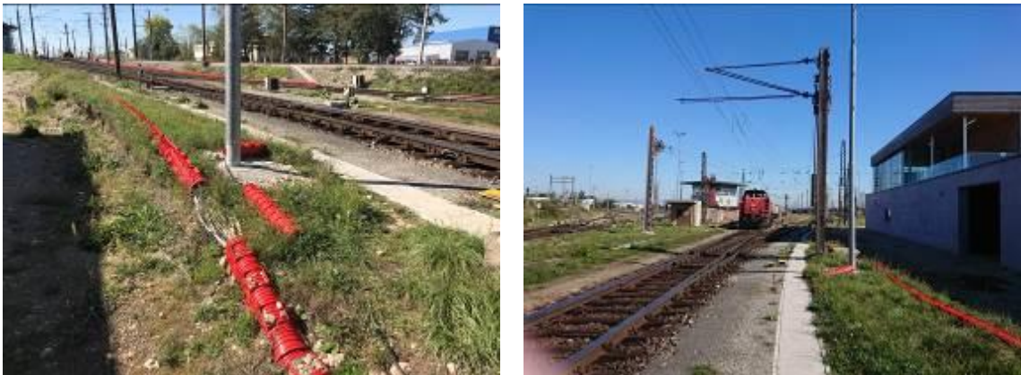
圖 5-3 臨時電纜使用硬殼塑膠保護管防護
