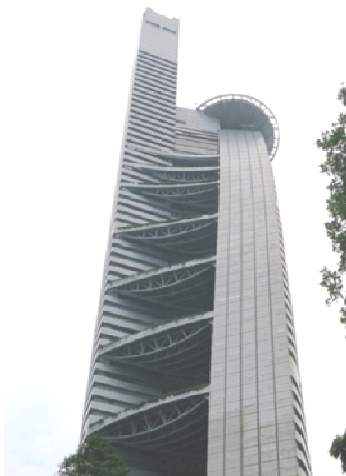
圖 50 馬來西亞電信公司總部大樓外牆上的深遮陽板
