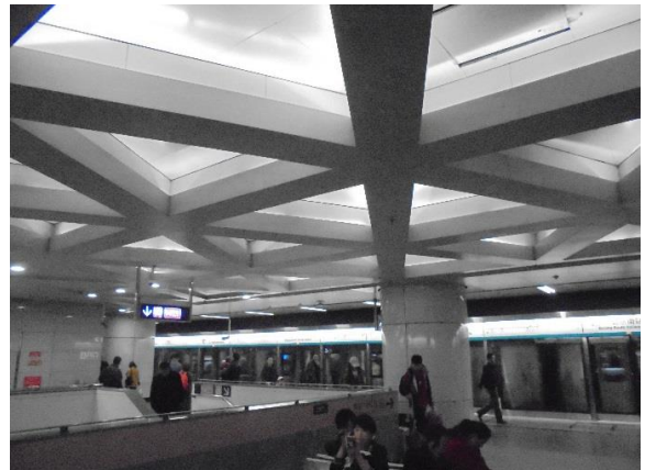
地鐵 4 號線北京南站
