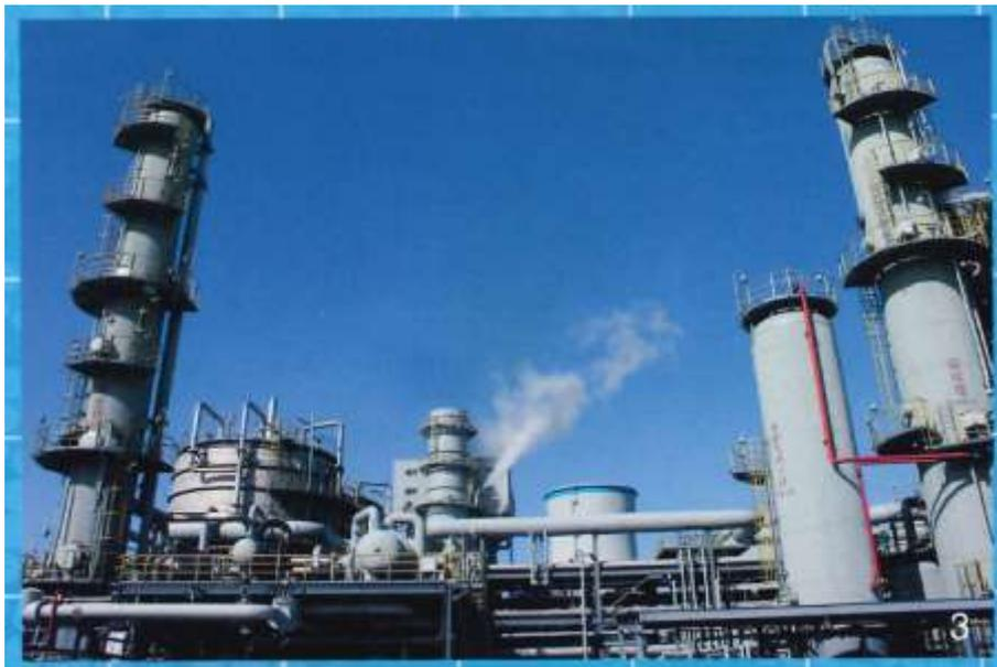
圖 4.4 合成氣淨化脫硫設備
