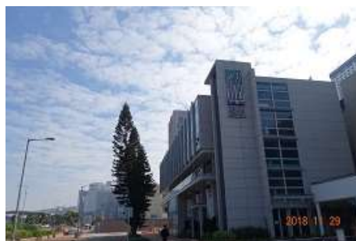
圖 18 座落於中環海邊的展城館建築
