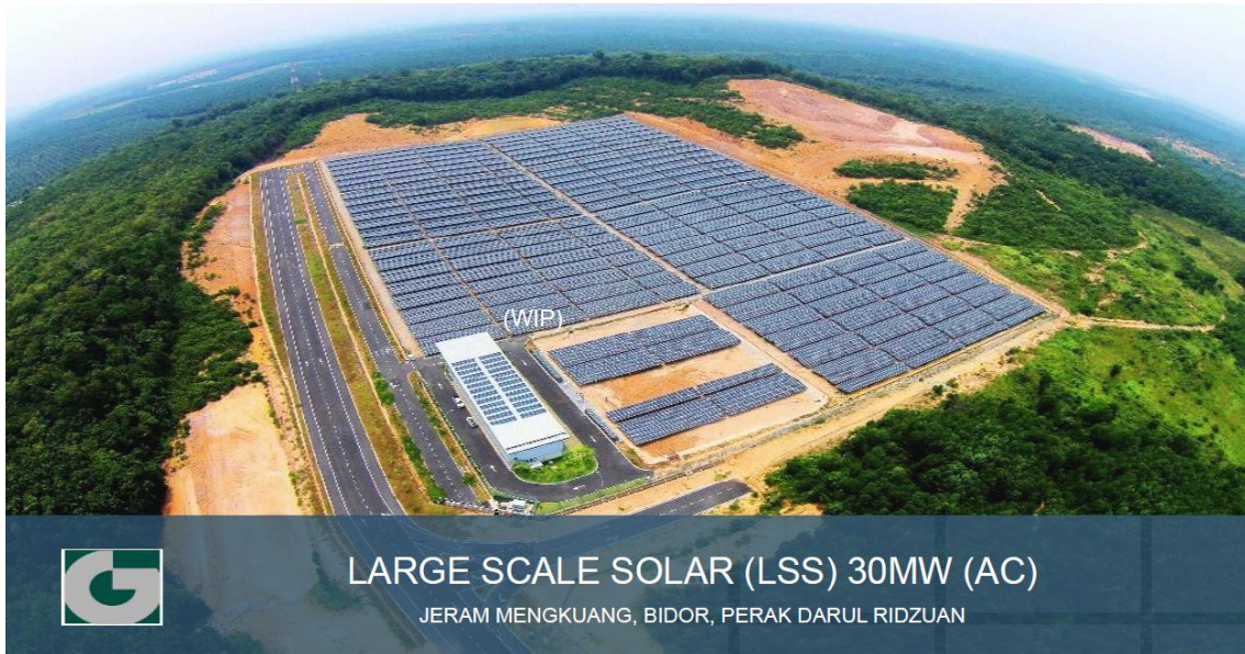
圖2、馬來西亞最大太陽光電廠裝置容量30MW
