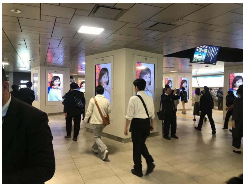
圖 68 池袋站內一景，照片中之樑柱為因應地震而再次加強結構，並以飾板及電子看板包覆。
