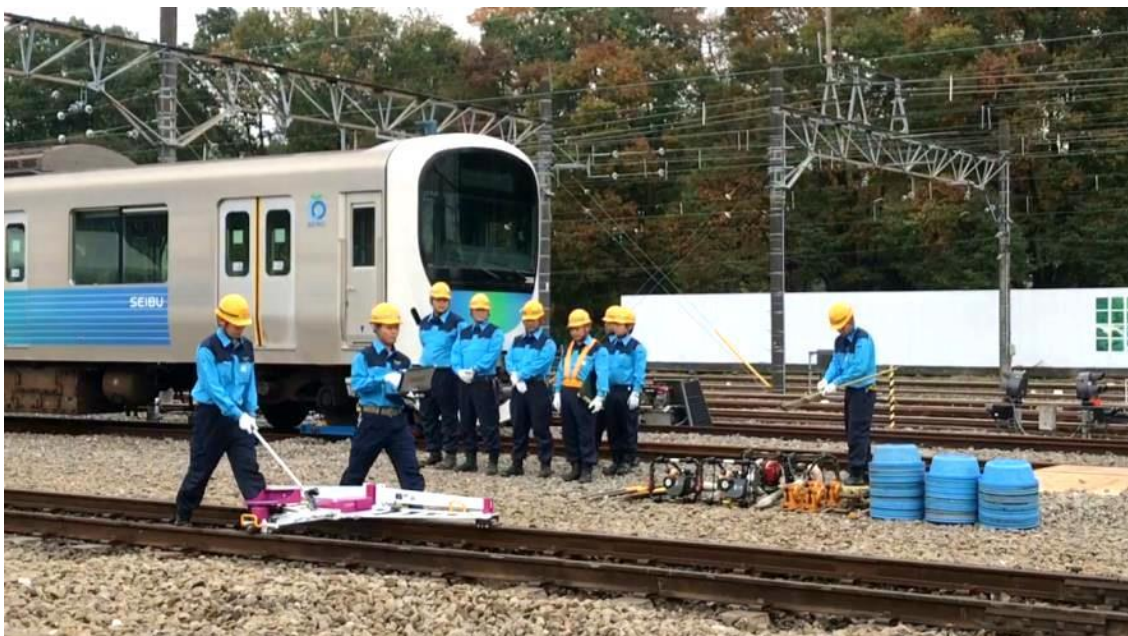
圖 22 軌道測量儀小台車檢測作業
