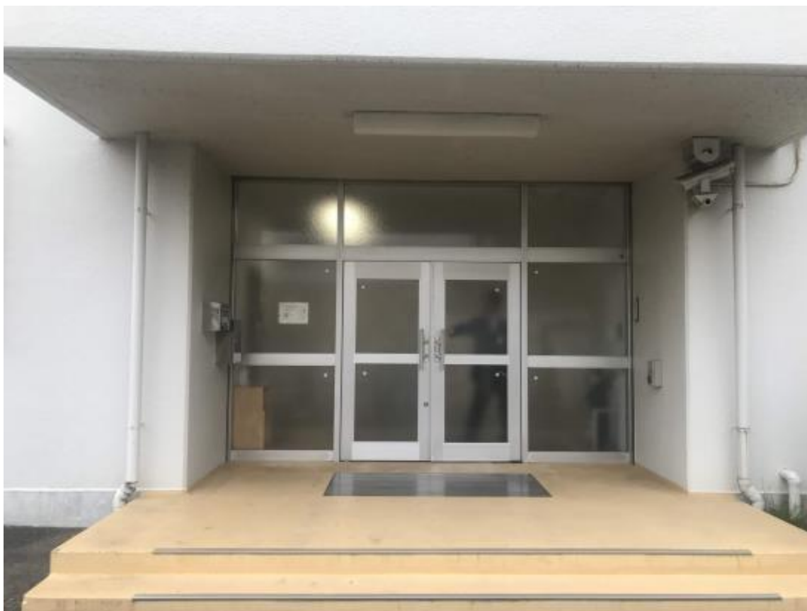
圖 34 西武鐵道司令所外觀，為安全考量其外觀無設置明顯銜牌
