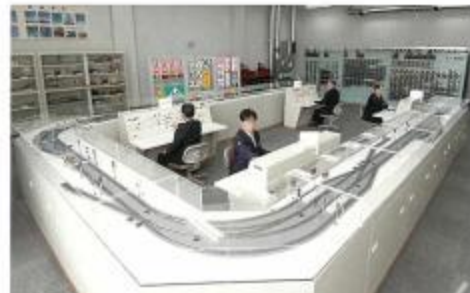
信号業務の実際が学べる駅用信号制御盤の模型(信号機器室)
