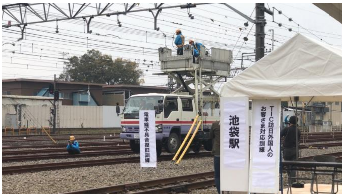
圖 26 電氣部以鐵公路兩用維修車搶修電車線
