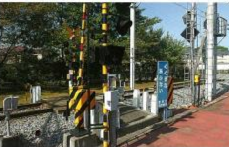
実物のレール、信号機、踏切、模擬架線などが設置され、実践的な実習・訓練が行える屋外教材
