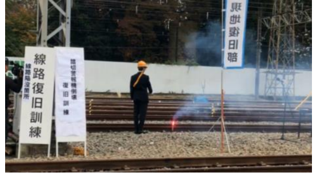
圖 7 司機員將火焰號訊固定於路線上
