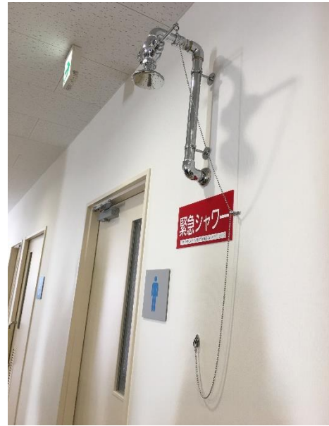
租賃實驗室樓層的公共空間設置緊急沖洗設備
