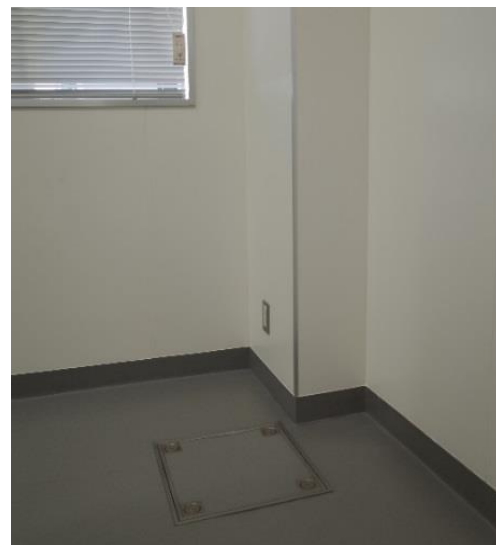
租賃實驗室備有排水系統預留孔及預留插座
