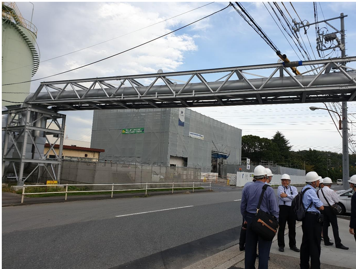
圖 3-4 名南共同エネルギー株式会社蒸汽輸送管線
