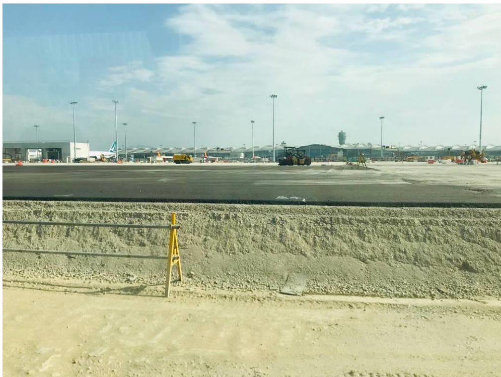
↑ 滑行道柔性道面施工示意圖
