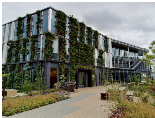
圖十 Park 20120 園區的 Plantronics 建築採用系統牆面與植物牆面
