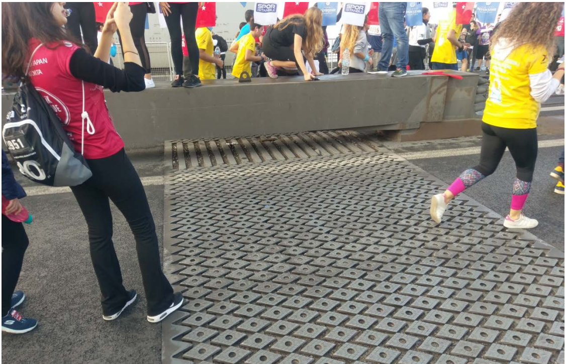
圖 3-1-2-12 第一大橋橋面及護欄伸縮縫(2)
