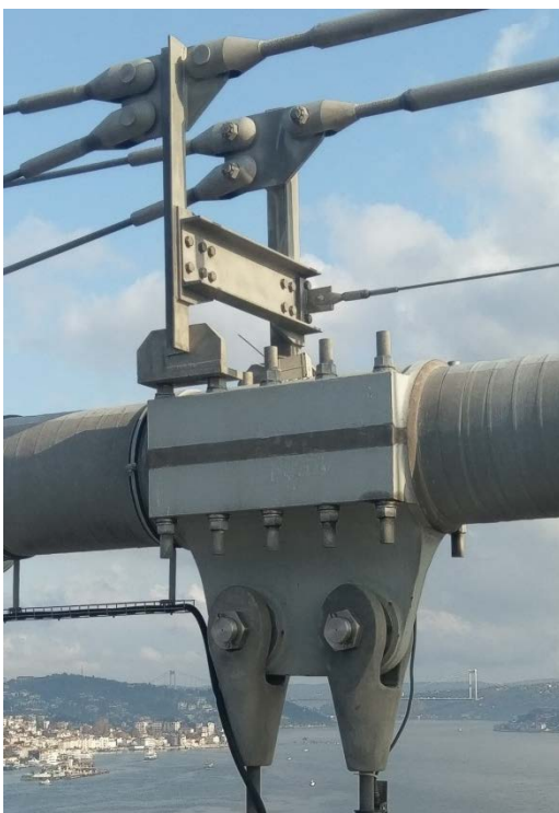
圖 3-1-2-7 第一大橋主纜及懸吊設施近照
