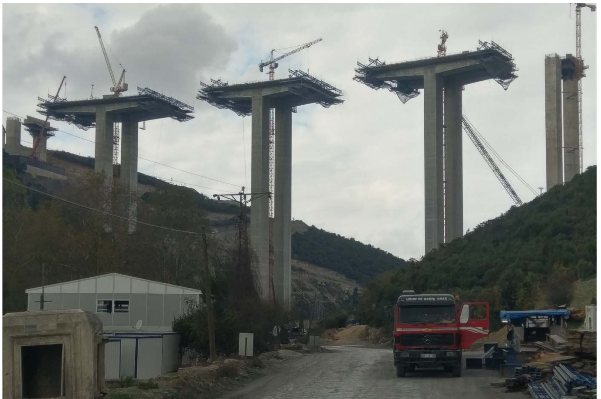
圖 3-4-2 Liman 高架橋懸臂工法段
