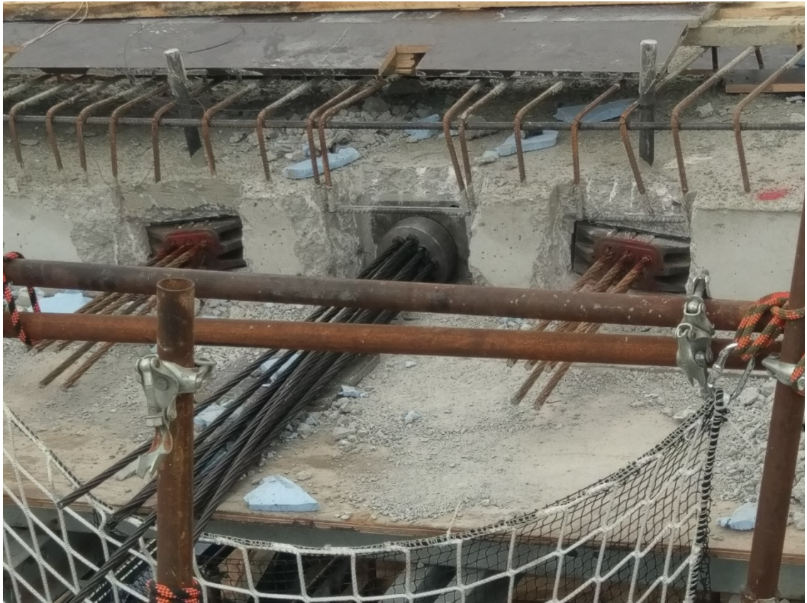
圖 3-4-7 Liman 高架橋橋面版肋梁預力端錨及錨座(1)
