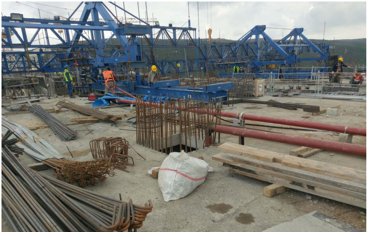
圖 3-4-6 Liman 高架橋懸臂工作車(2)
