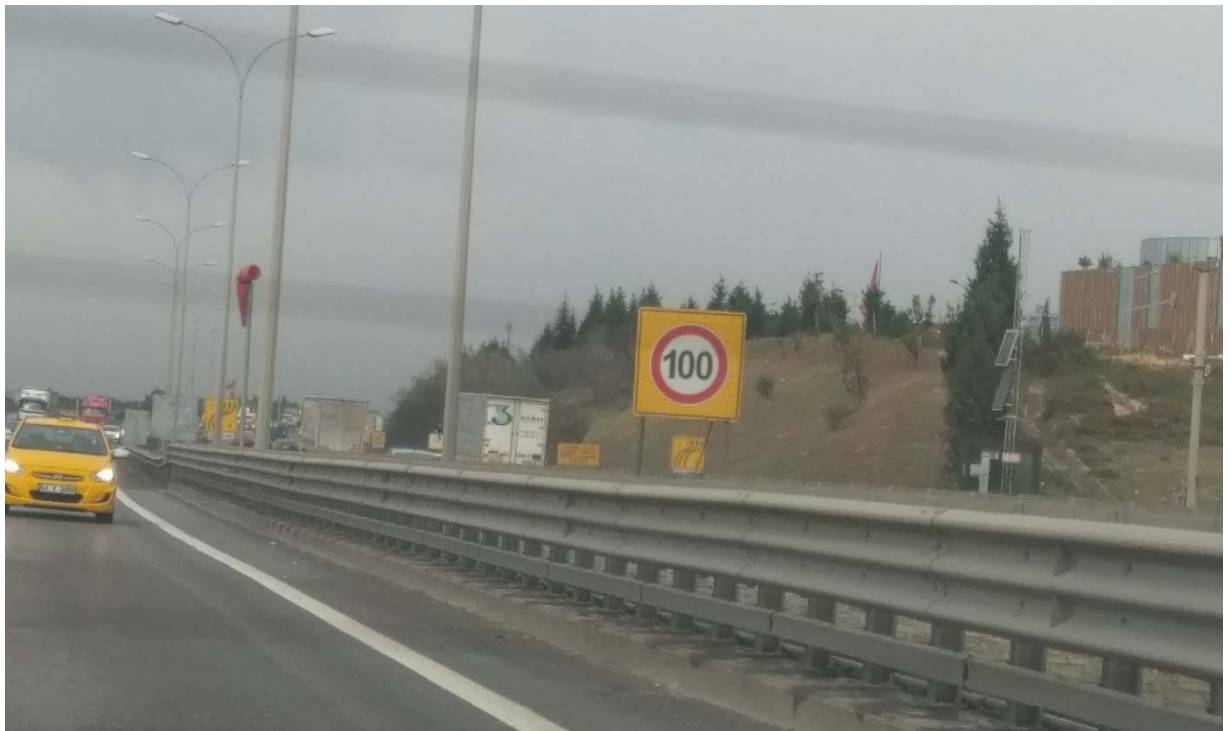
圖 3-5-11 O-5 公路施工指示牌面
