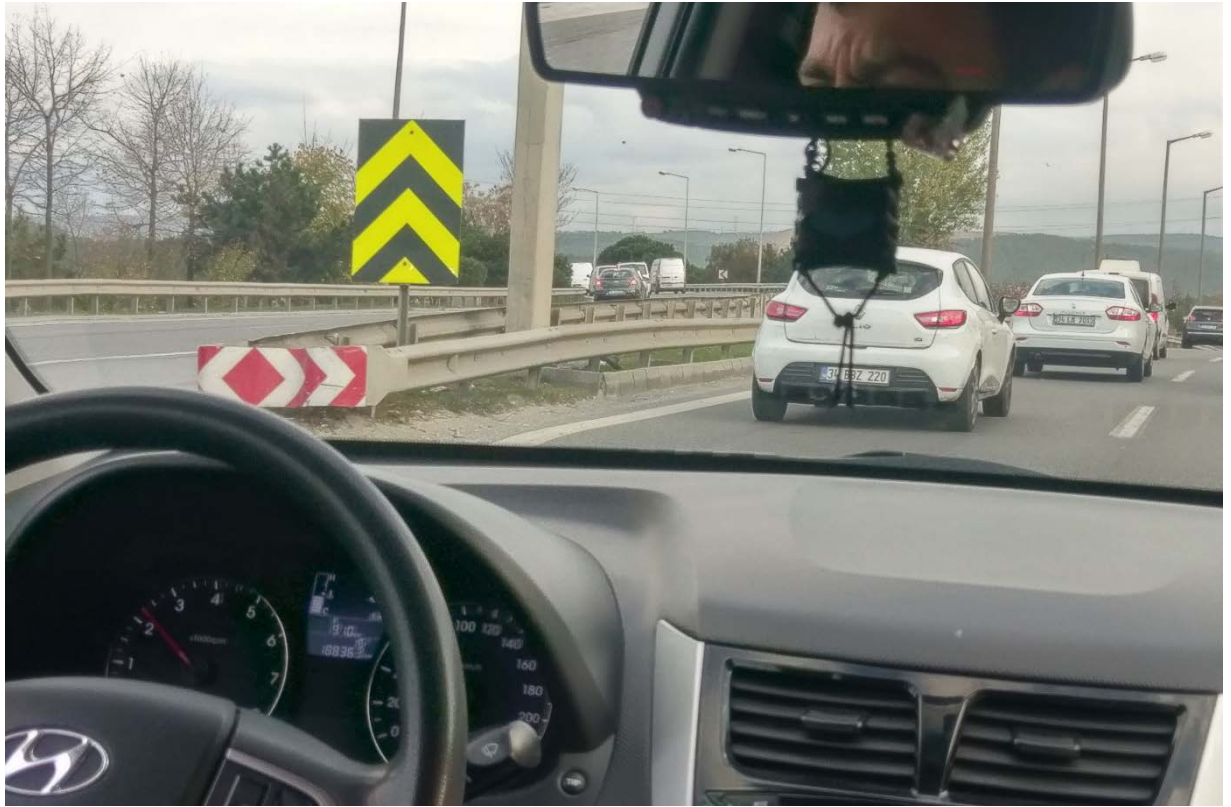
圖 3-5-8 O-5 匝道鼻端護欄及警示設施
