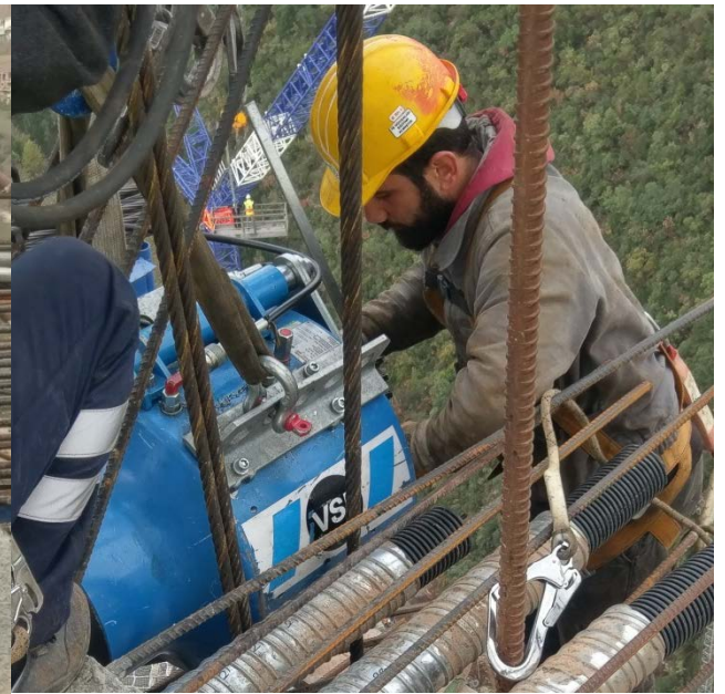
圖 3-4-9 Liman 高架橋懸臂工法預力系統施拉設備
