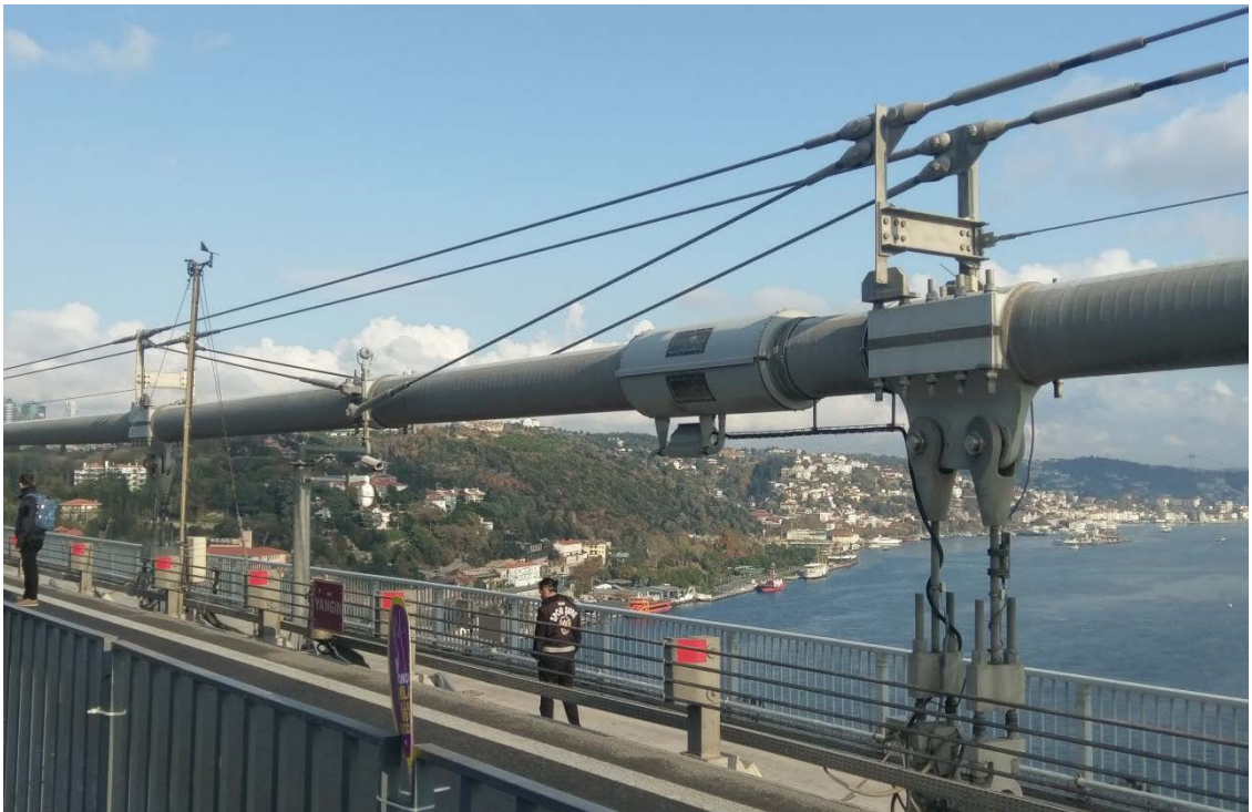
圖 3-1-2-7 第一大橋主纜及懸吊設施近照
