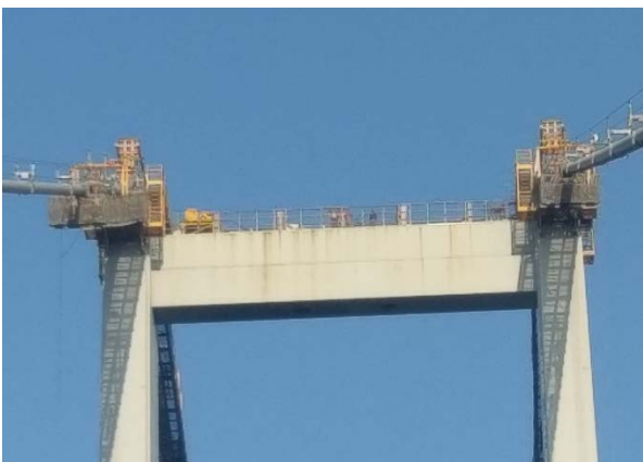
圖 3-1-2-5 第一大橋主纜檢修車及阻絕柵欄近照
