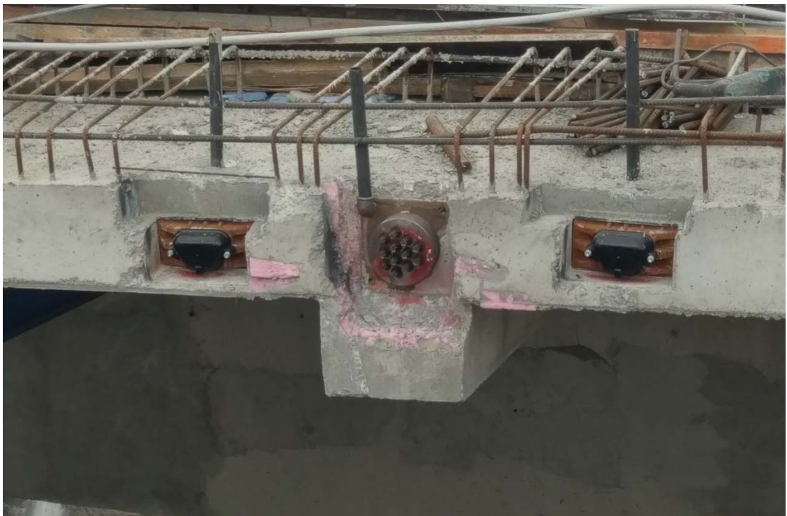
圖 3-4-8 Liman 高架橋橋面版肋梁預力端錨及錨座(2)
