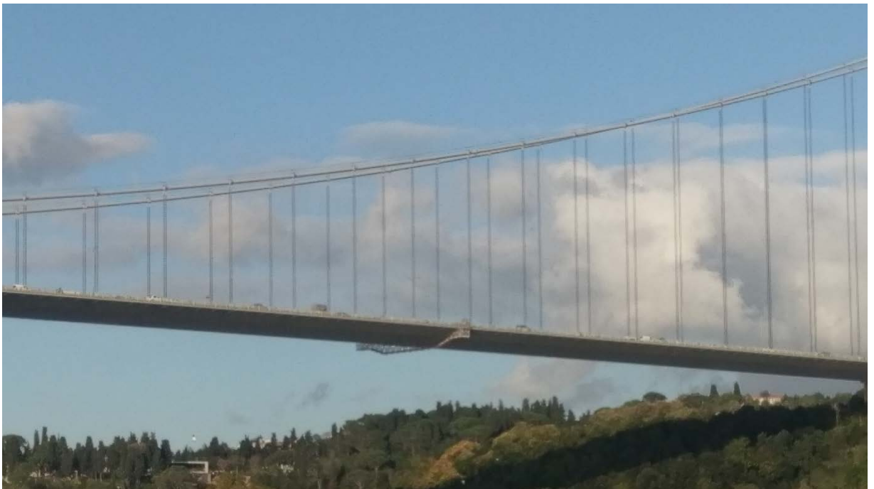
圖 3-2-1-2 第二大橋橋面下檢修步道
