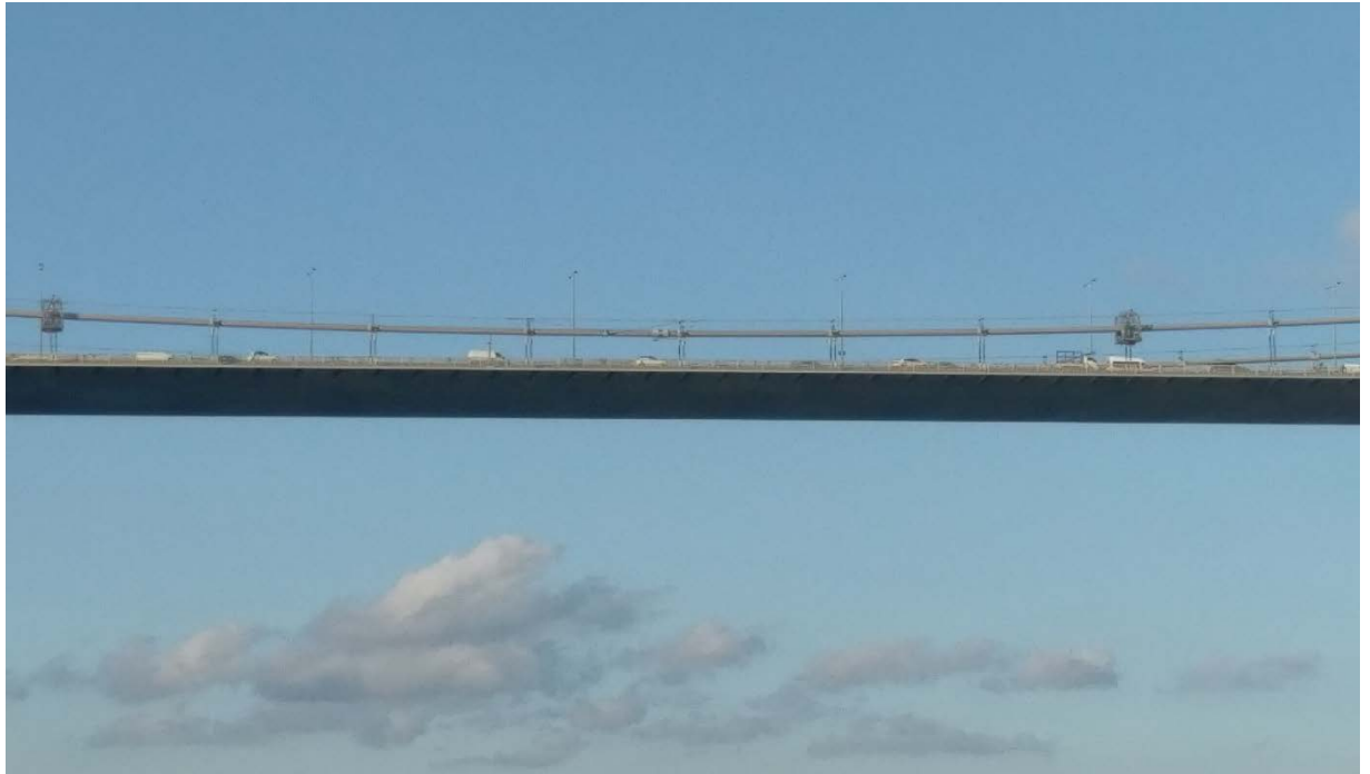
圖 3-2-1-3 第二大橋主纜索檢修車
