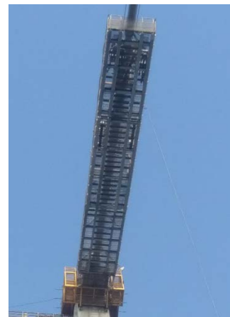
圖 3-1-2-5 第一大橋主纜檢修車及阻絕柵欄近照
