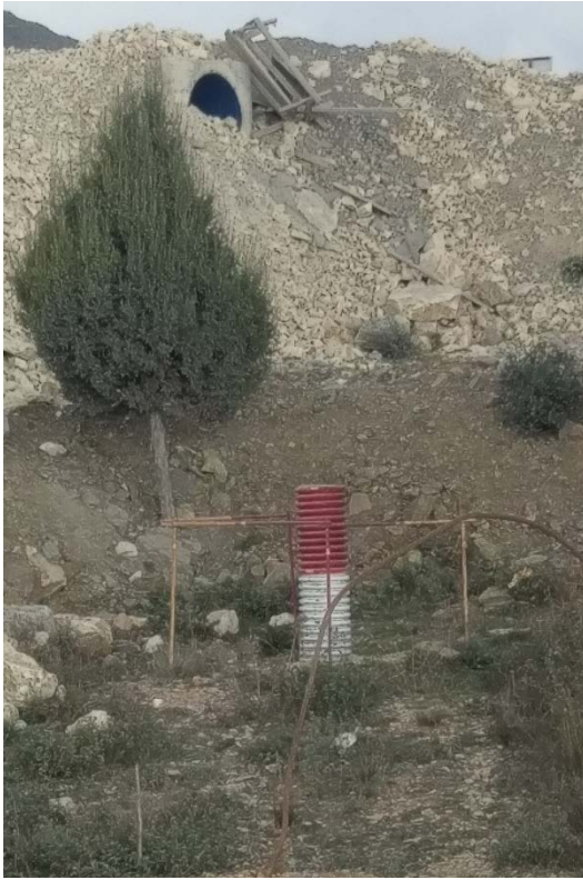
圖 3-4-14 Liman 高架橋工區測量基準點
