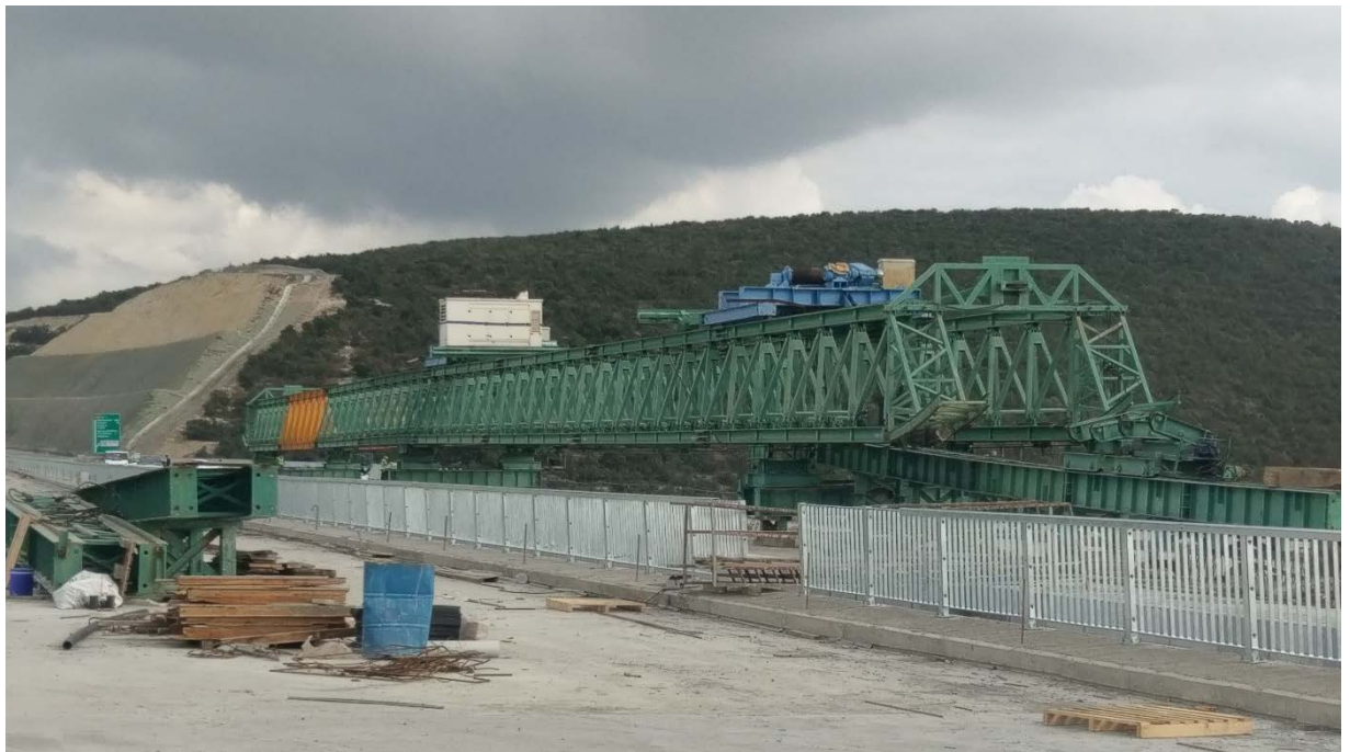
圖 3-4-13 Liman 高架橋 PCI 梁吊梁車
