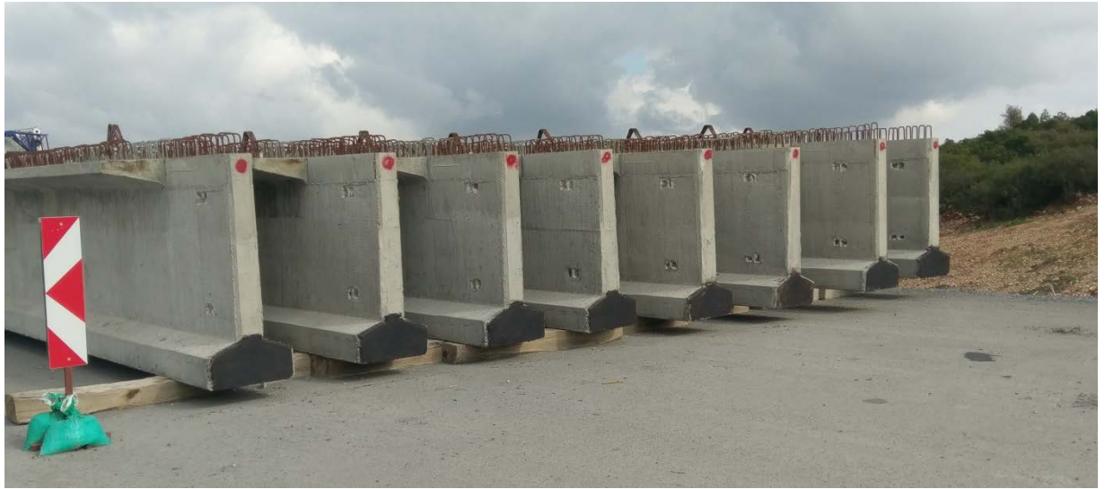
圖 3-4-12 Liman 高架橋 PCI 梁場
