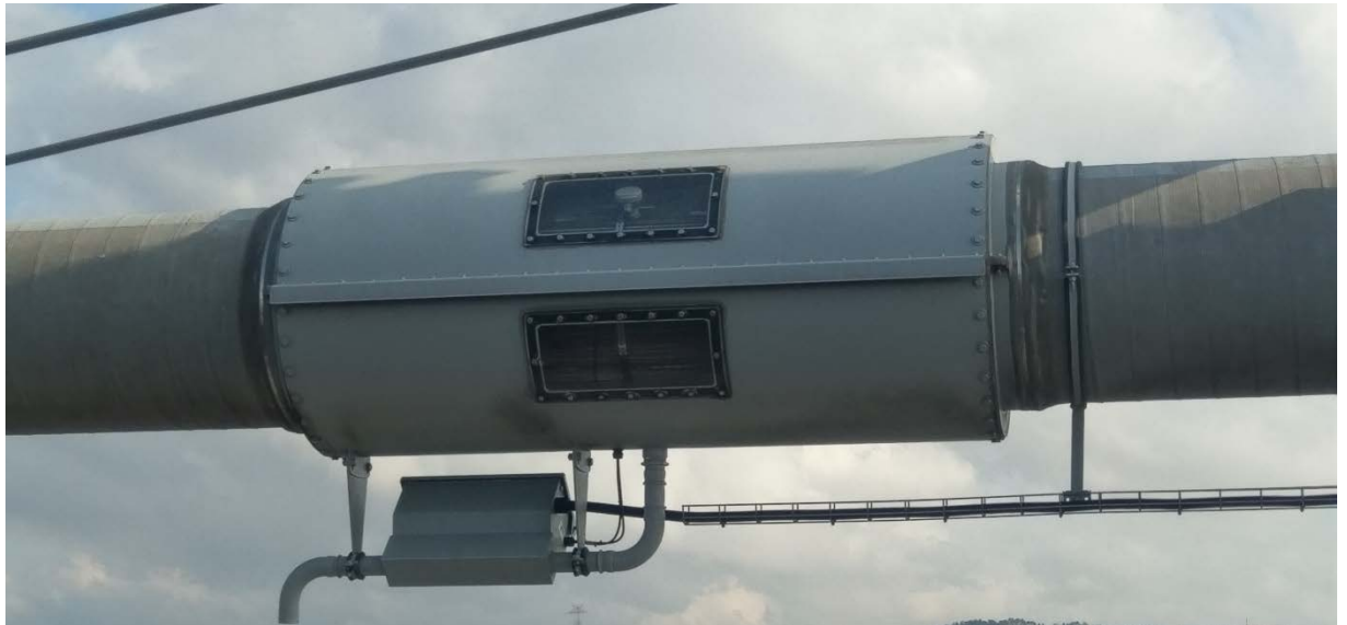
圖 3-1-2-10 第一大橋主纜鋼索檢視窗
