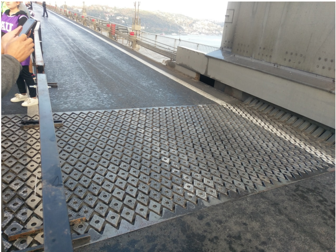
圖 3-1-2-11 第一大橋橋面及護欄伸縮縫(1)
