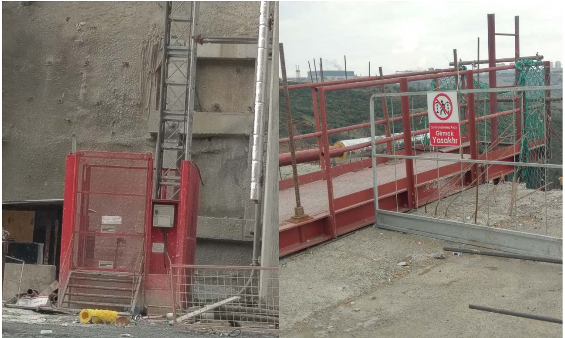
圖 3-4-15 Liman 高架橋懸臂工法工作區上下設備
