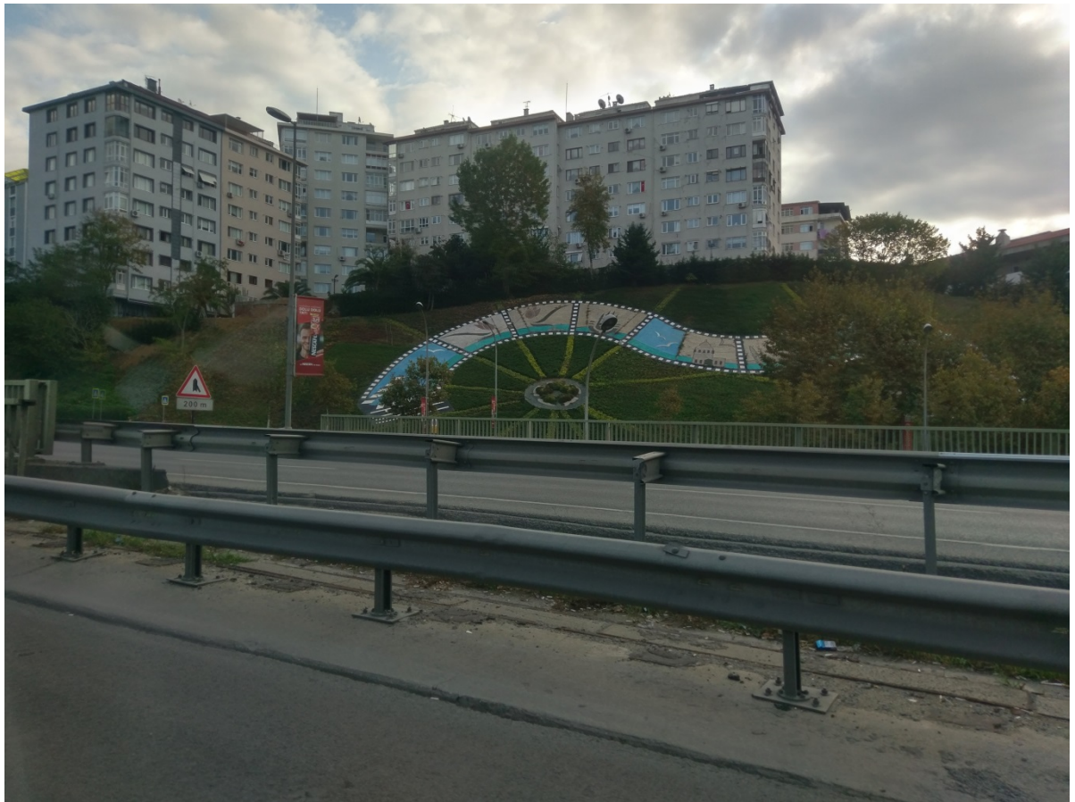
圖 3-5-2 O-5 公路主線邊坡及護欄(1)
