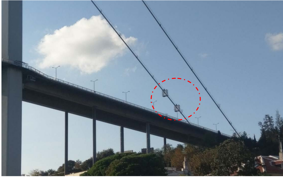
圖 3-1-1-5 第一大橋主纜索檢修車
