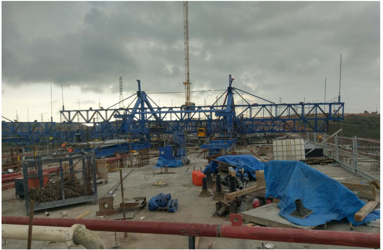
圖 3-4-5 Liman 高架橋懸臂工作車(1)
