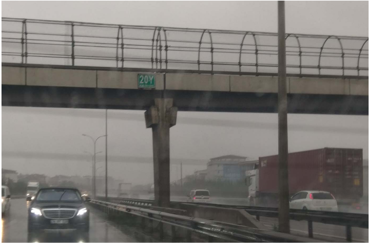
圖 3-5-14 O-5 公路橋墩柱耐震補強(1)
