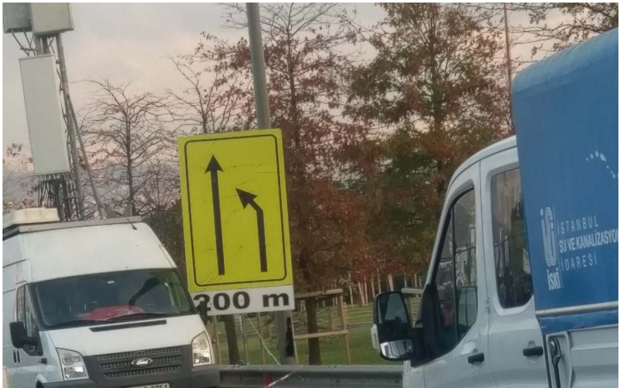
圖 3-5-9 O-1 公路施工改道牌面
