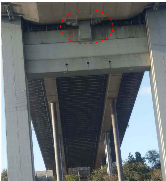
圖 3-1-1-4 第一大橋橋梁新設止震裝置
