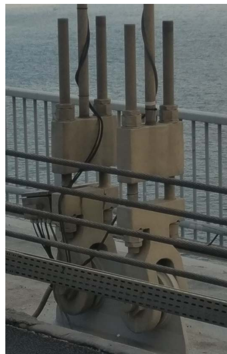
圖 3-1-2-7 第一大橋主纜及懸吊設施近照
