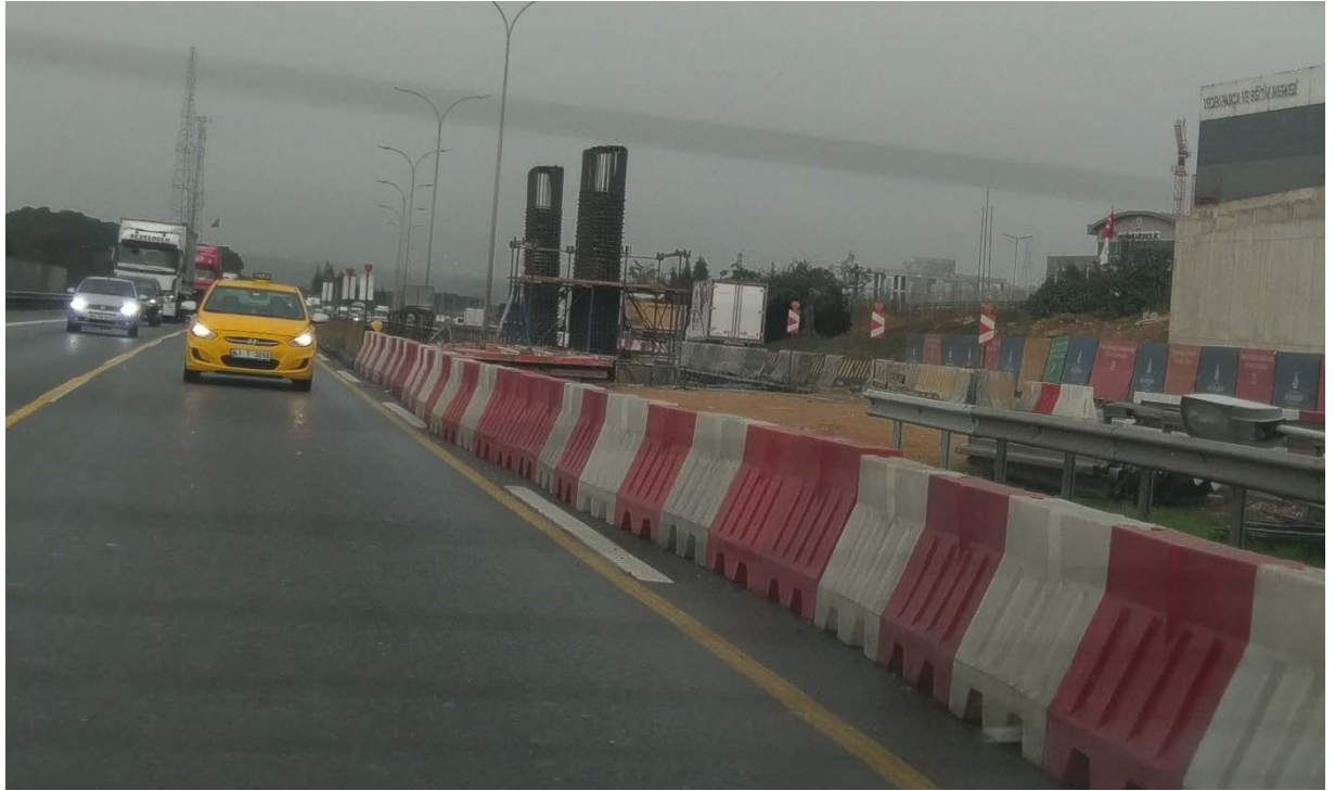
圖 3-5-12 O-5 公路施工護欄及施工架(1)
