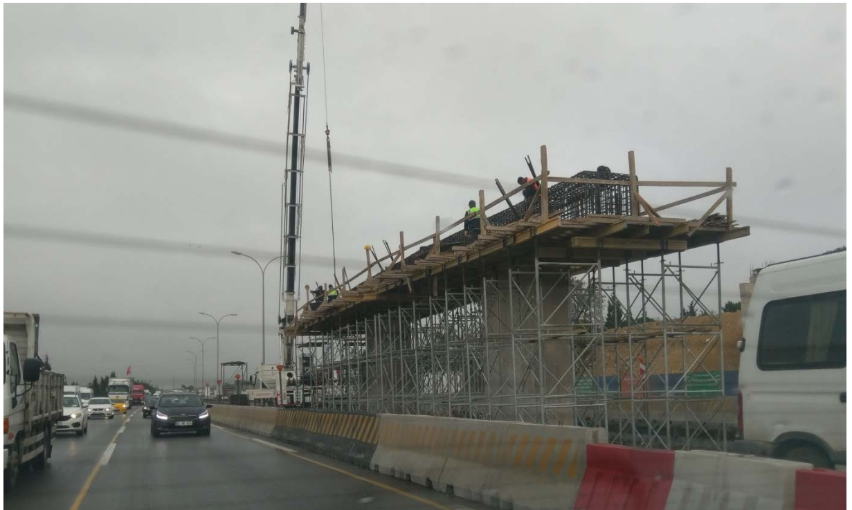
圖 3-5-13 O-5 公路施工護欄及施工架(2)
