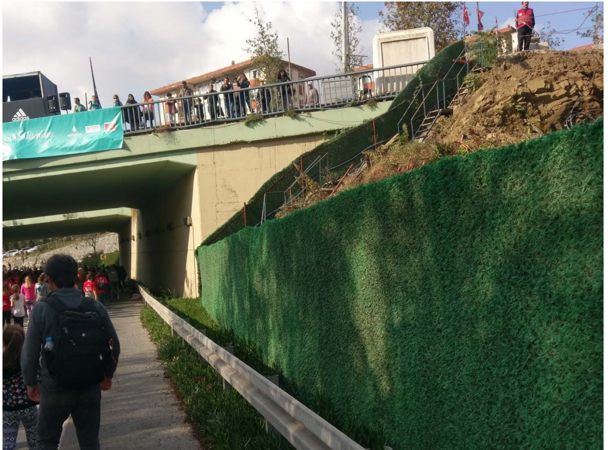
圖 3-5-20 O-1 公路聯絡道旁施工圍籬綠籬
