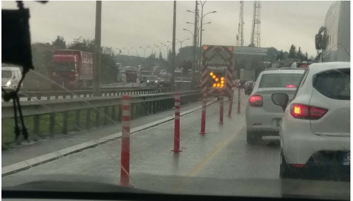
圖 3-5-10 O-5 公路施工 LED 導引牌面
