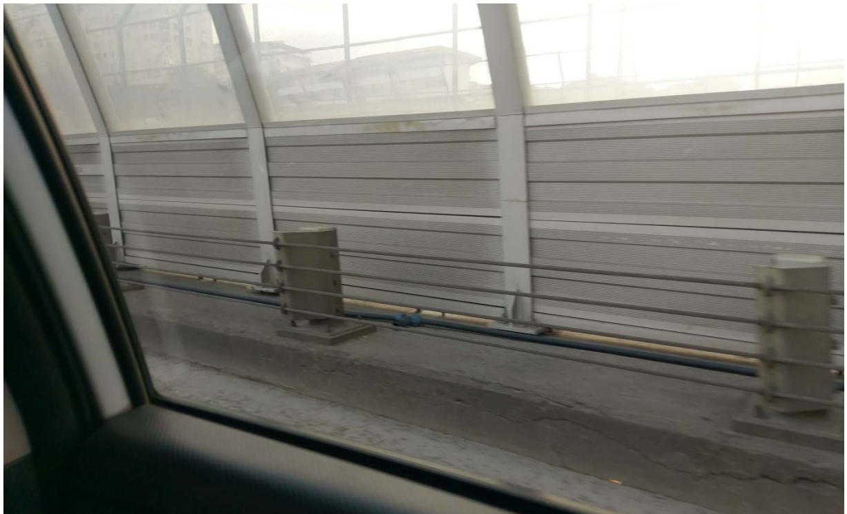
圖 3-5-3 O-5 公路鋼索式護欄
