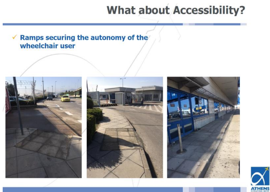
【圖 26 希臘雅典機場路緣無障礙斜坡 1 景】
