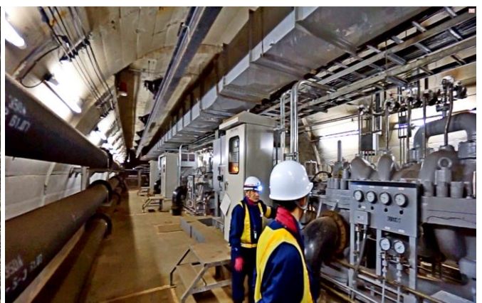
照片 3.4-8 P3 排水基地排水設備
