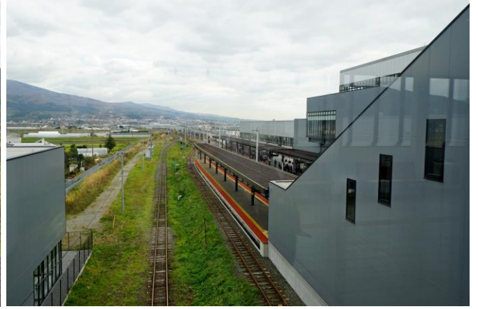
照片 3.5-8 新函館北斗車站往函館方向現況
