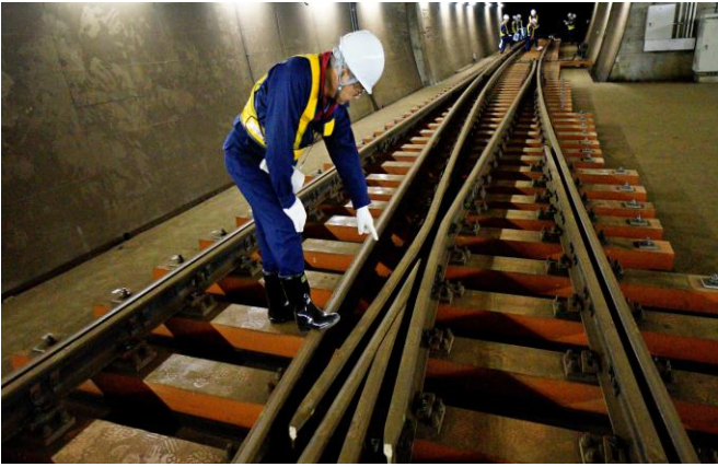
照片 3.4-9 橫取基地三軌道岔
