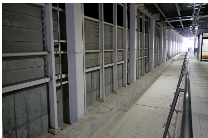
照片 3.5-1 新函館北斗車站未來往札幌月台現況
