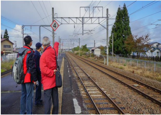
照片 3.3-3 JR 神宮寺站窄軌(左邊)及寬軌(右邊)軌道配置情形
