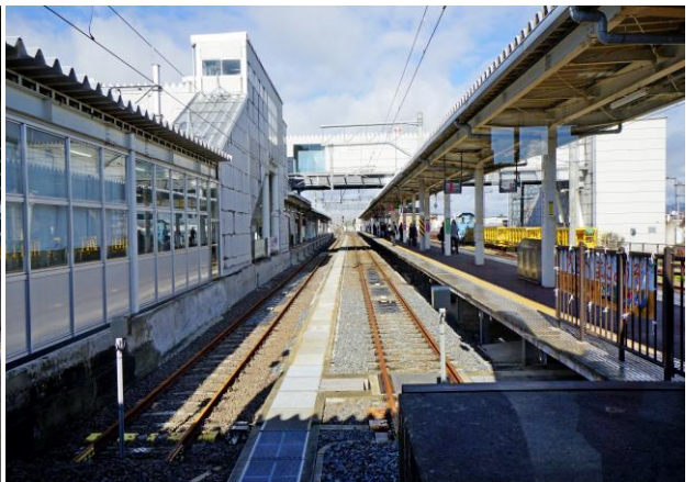
照片 3.3-8 JR 大曲站新幹線月台(左邊軌道為傳統鐵路使用)
