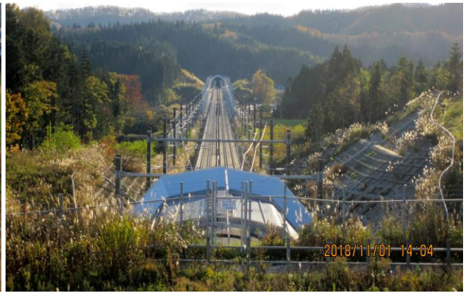
照片 3.4-2 知内町湯の里信號站 往青函隧道方向現況
