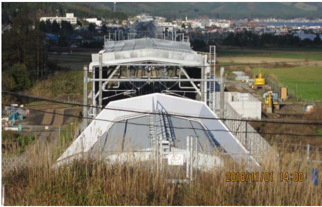
照片 3.4-1 知内町湯の里信號站 往 JR 木谷内站方向現況
