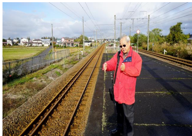
照片 3.3-2 JR 神宮寺站三軌軌道現況
