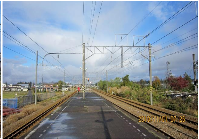
照片 3.3-4 JR 神宮寺站月台左邊為三軌中間為窄軌、右邊為寬軌軌道
