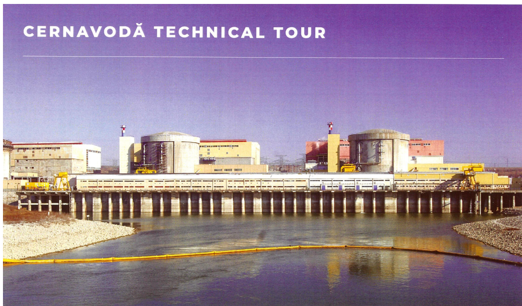
參訪切爾納沃德(Cernavoda Nuclear Power Plant)核能發電廠 (圖片取自會議的紙本資料)
