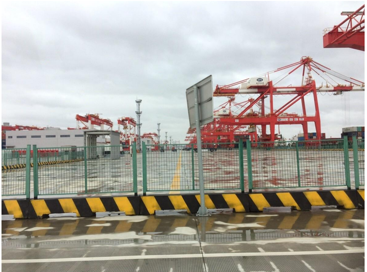
圖 13 上海洋山四期碼頭後線儲區作業
