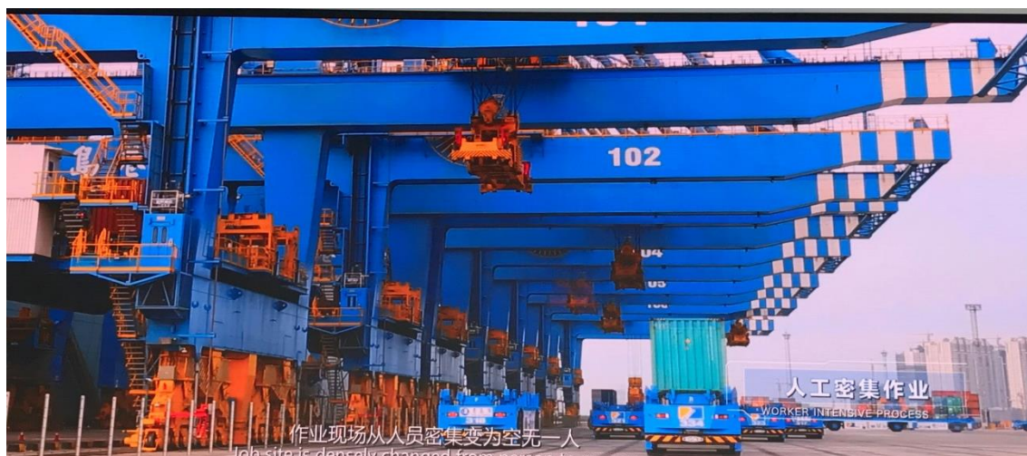
圖 28-自動導引車 AGV 作業及待命
