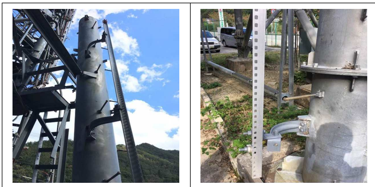
圖 5、鋼管桿裝設防墜裝置
