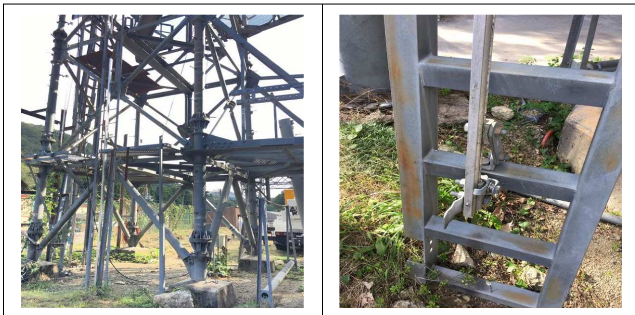
圖 4、鐵塔裝設爬梯並搭配防墜裝置
