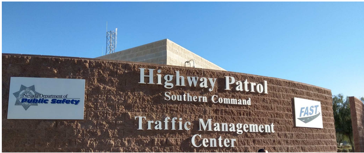
圖 20 南內華達州高速公路與幹道運輸系統交通控制中心
