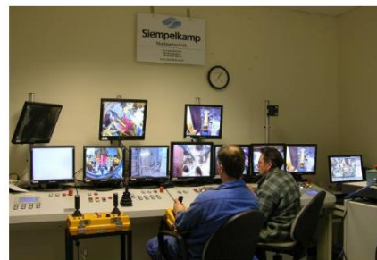
圖十、遙控拆除 MZFR 生物屏蔽牆
