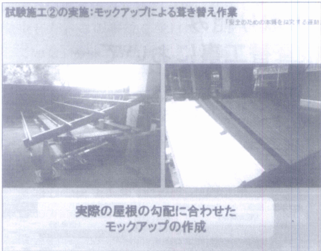
圖2 實際屋頂整修工程試驗施工
