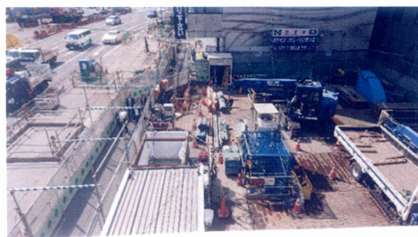
横濱市工地物料堆放整齊
