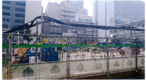
工地電纜確實架高
