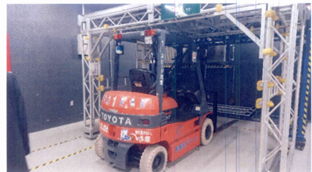
後台施工架均裝設護套
