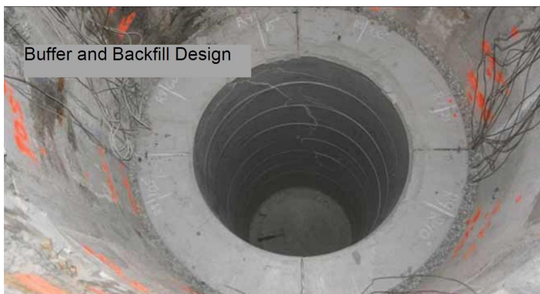
圖 14-膨潤土於處置孔中安裝情形
