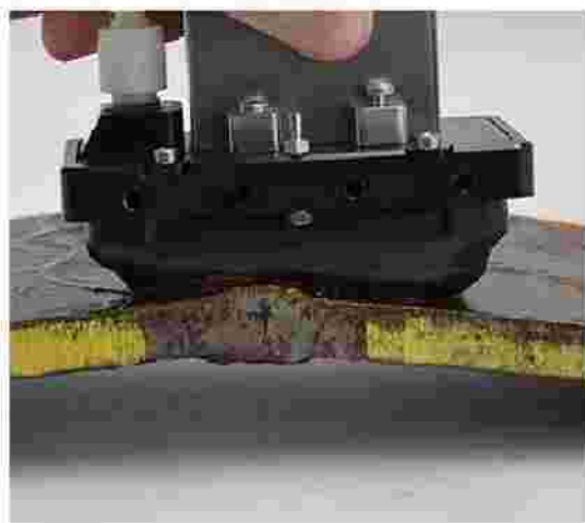
有瑕疵的彎曲的鋼管截面 以彈性楔塊進行檢測
