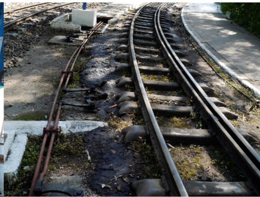
寬軌淘汰後鋼枕替換至窄軌鐵路
