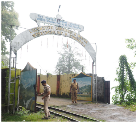
Tindharia 火車修理工廠入口處
