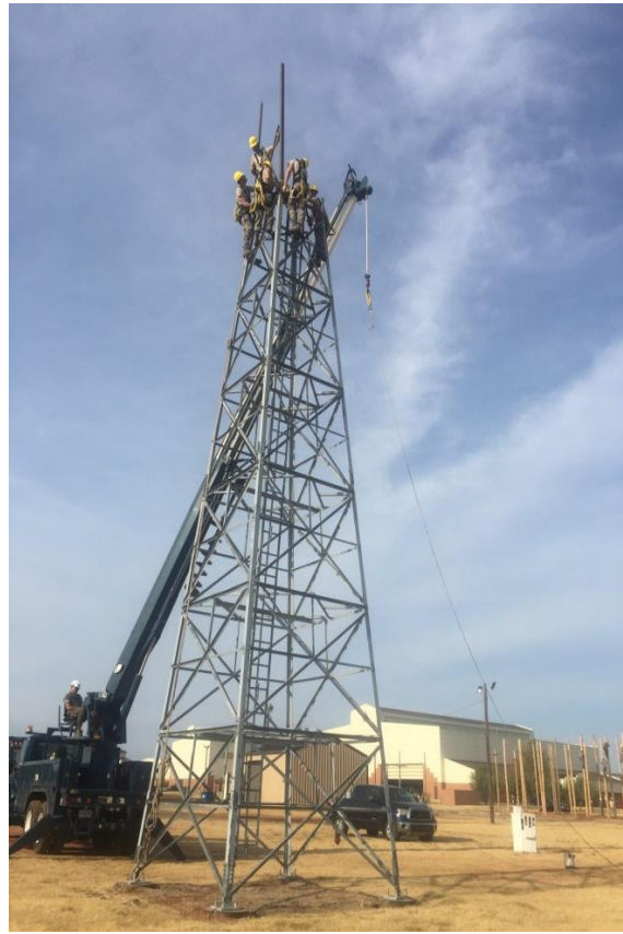
[執行鐵塔架設]
