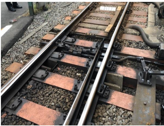
圖 59 轉轍拉桿與拐軸部分
