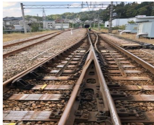
圖 50 松代站可動式岔心道岔
