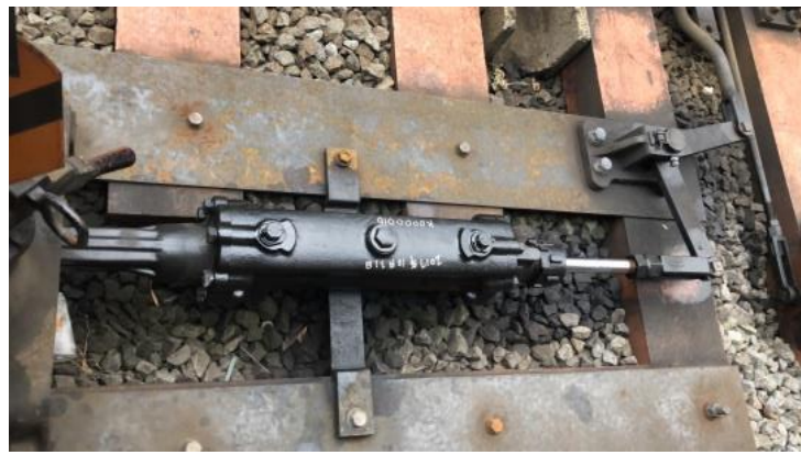
圖 58 轉轍器油壓缸近照
