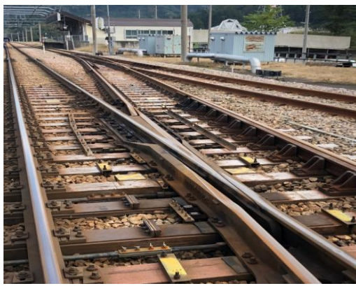
圖 50 松代站可動式岔心道岔
