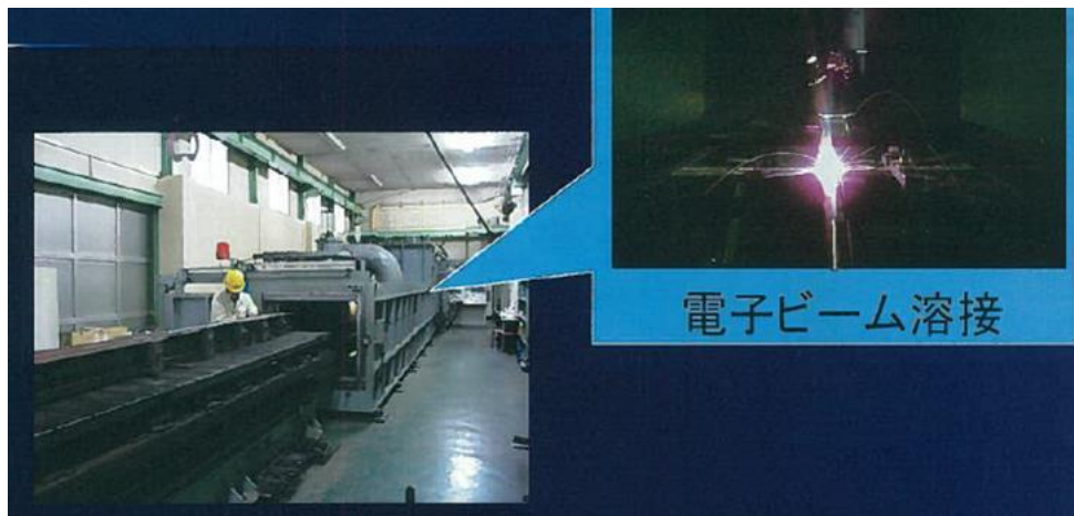
圖 10 鋼軌縱向焊接-電子溶接設備
