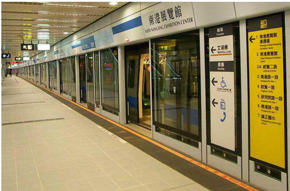
圖 21 臺北捷運板南線南港展覽館站月台門
