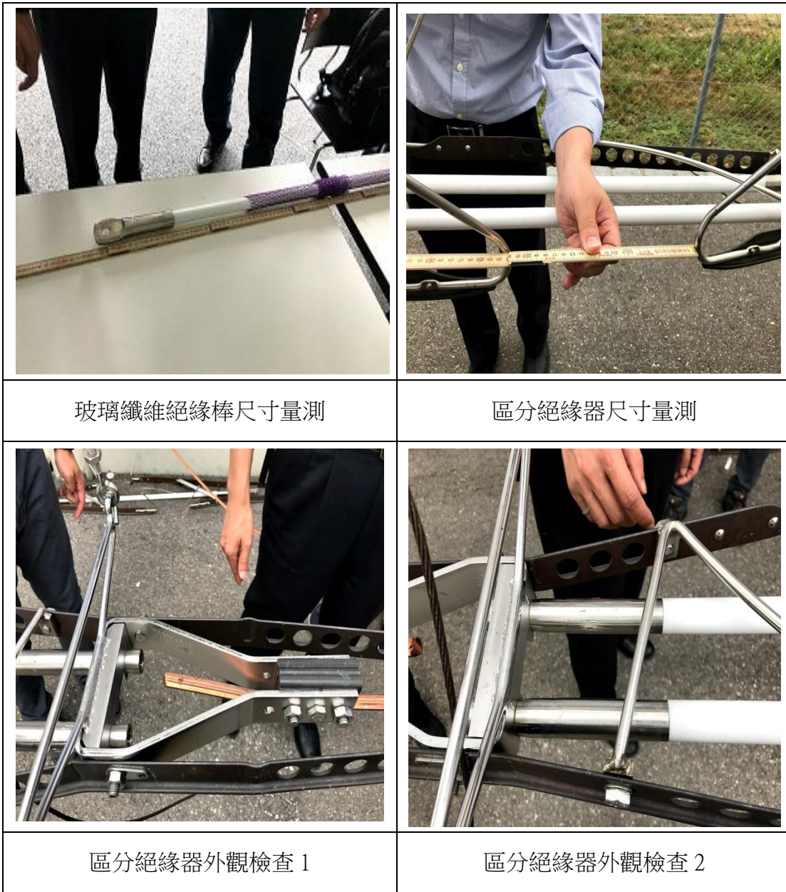
圖 4-5 區分絕緣器中間檢查作業
