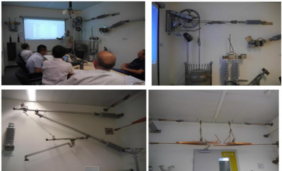
圖 3-1 會議室簡報及西門子電車線設備展示
