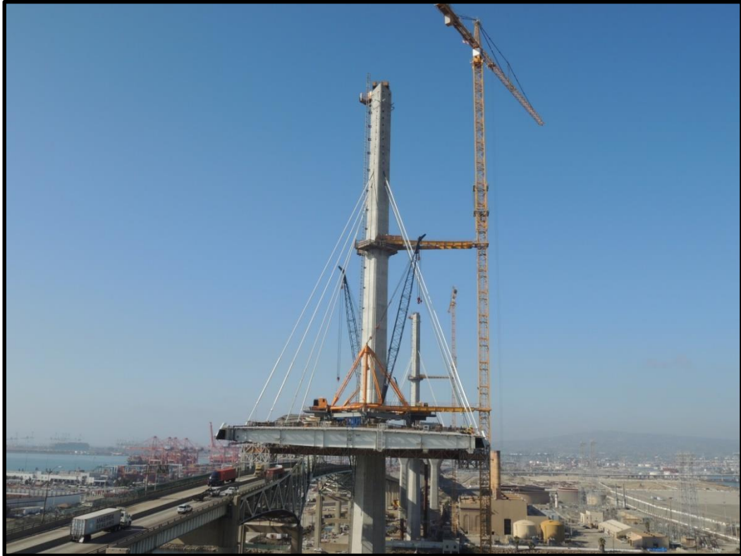
New Gerald Desmond Bridge 施工現況
