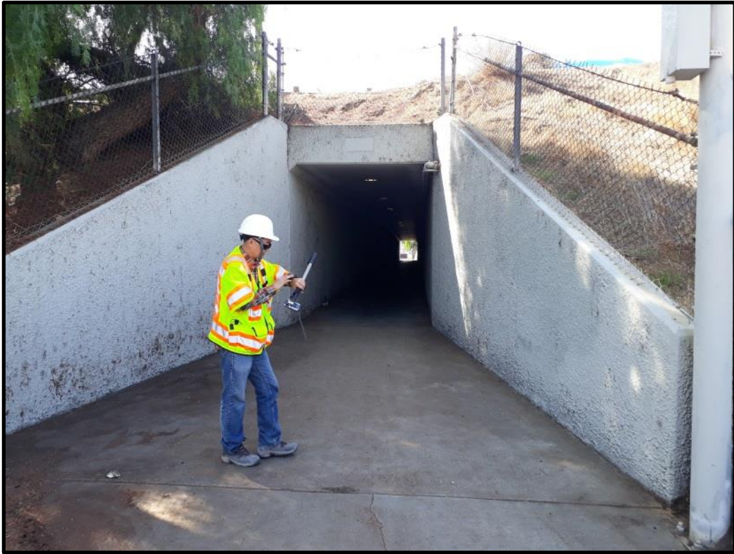
人行涵洞檢測作業
