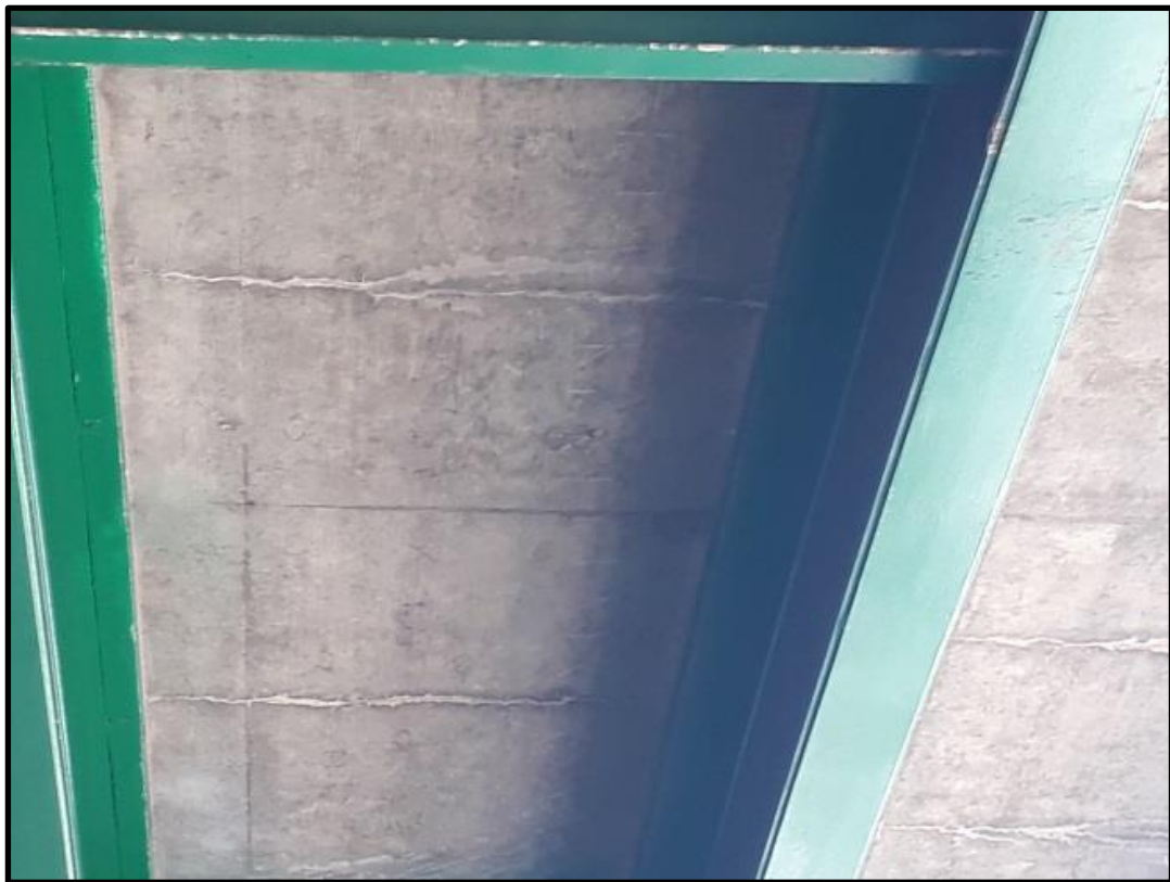
參與 Western Ave Bridge 橋檢作業時發現橋面版已有白華產生
