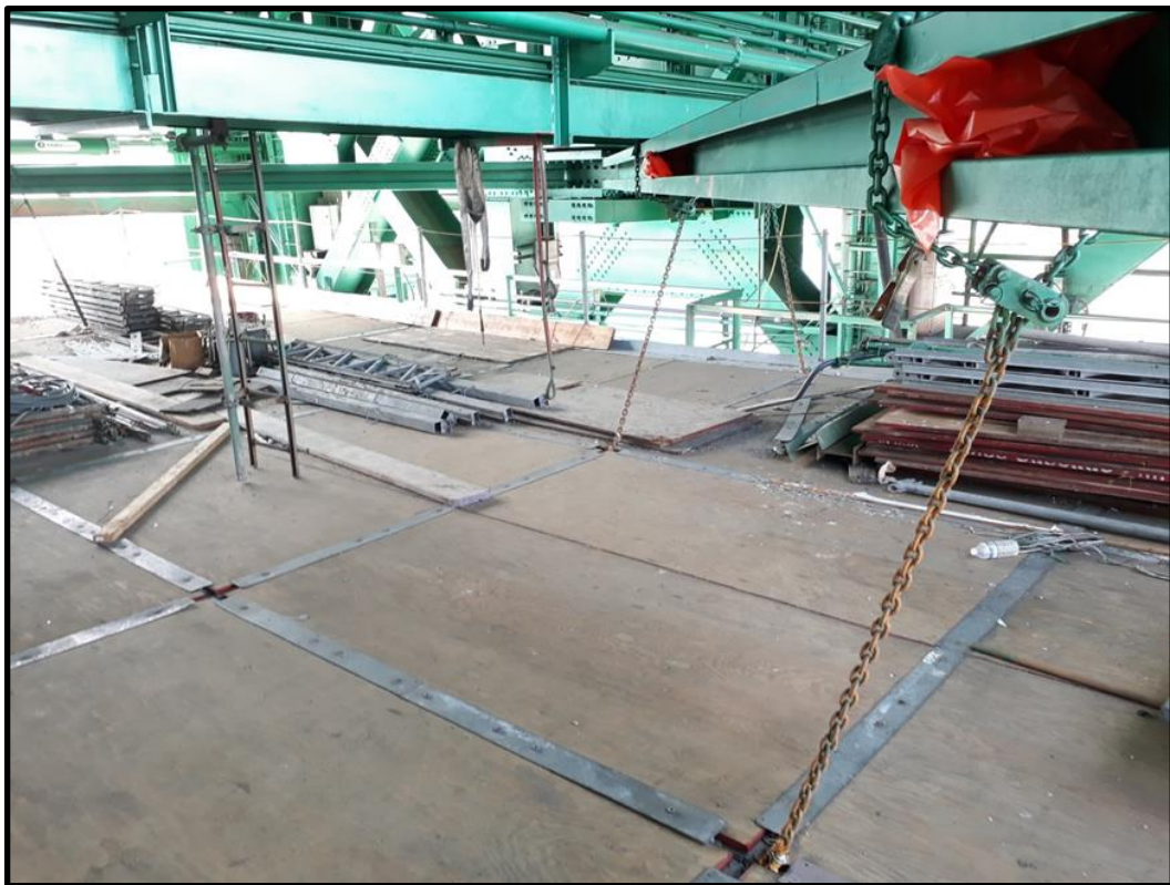
空中臨時施工平台(Vincent Thomas Bridge)
