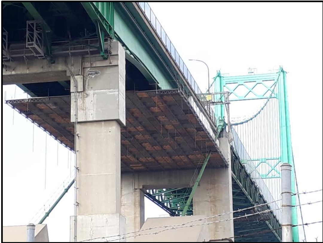
空中臨時施工平台(Vincent Thomas Bridge)
