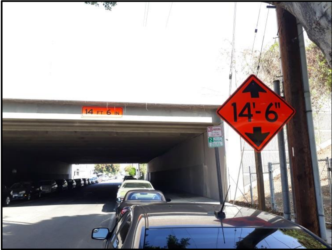
Allen Ave Bridge 檢測作業
