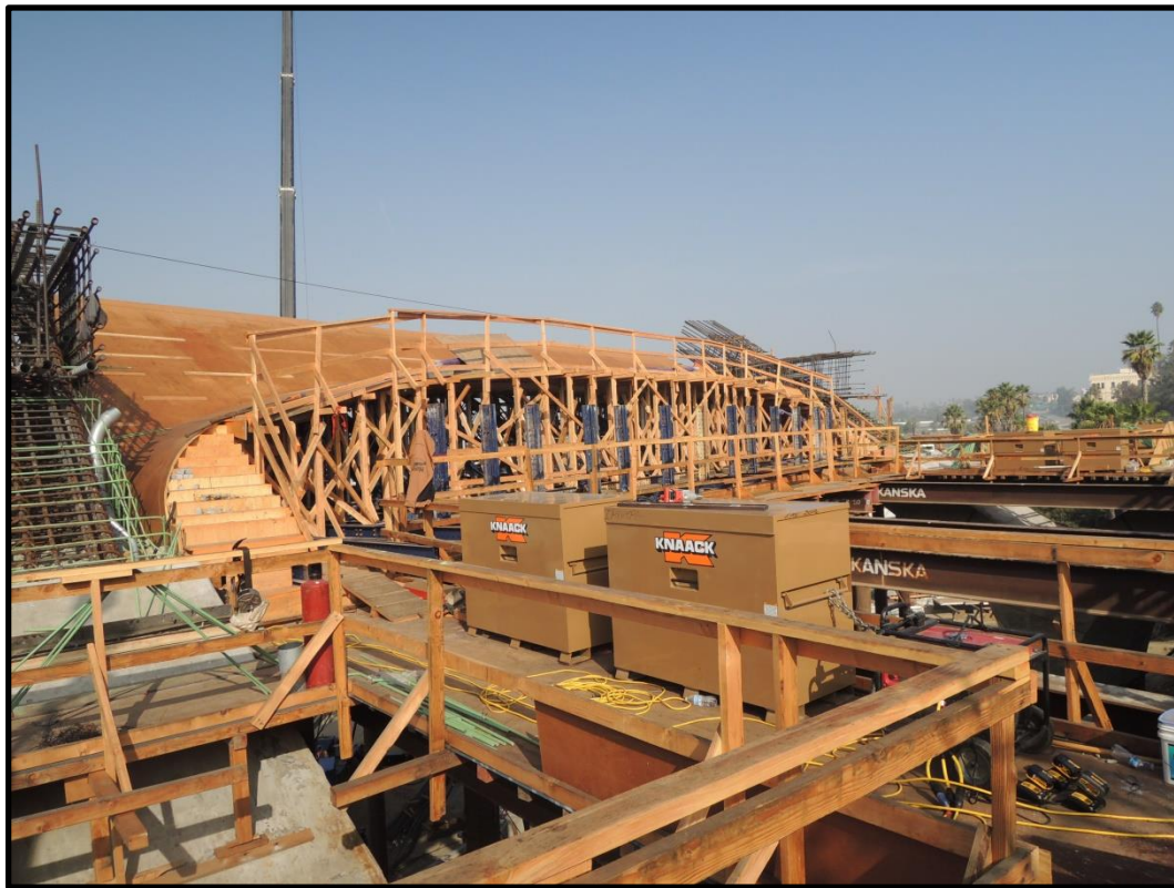
參觀 Sixth Street Viaduct Replacement Project 新建工程
