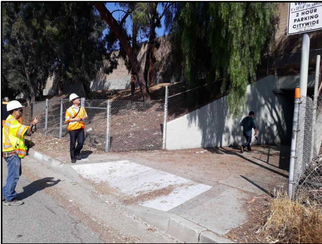
人行涵洞檢測作業
