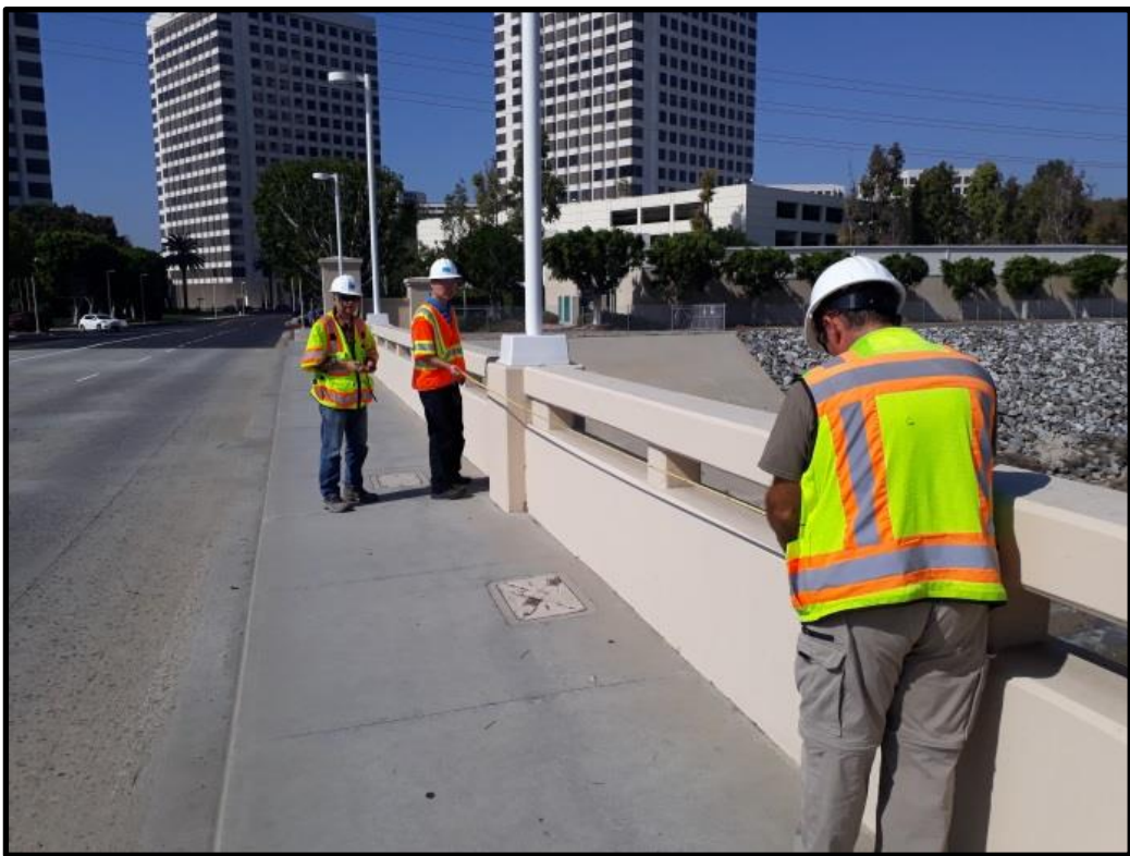
爾灣(Irvine)Coronado Street Bridge 聖地牙哥河河床斷面量測作業
