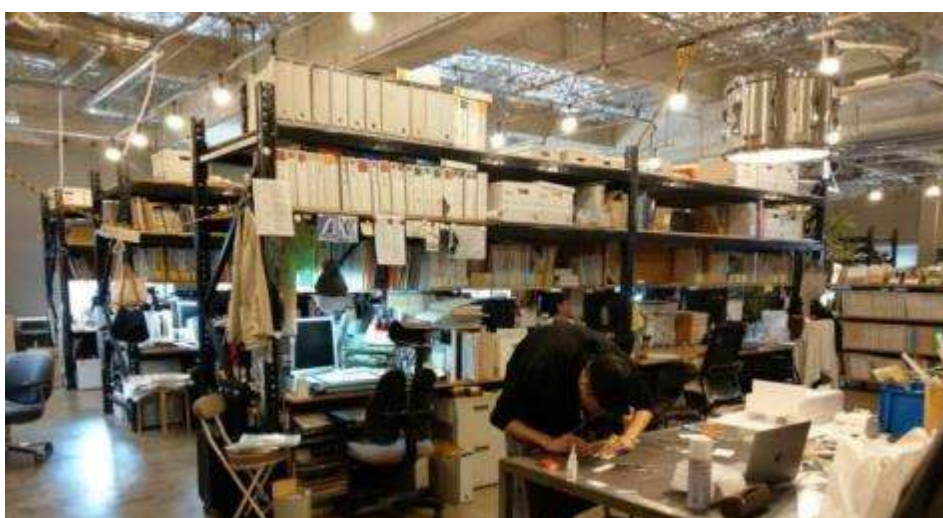
▼拆除吊頂與透明漆，呈現建物原有的高挑感
