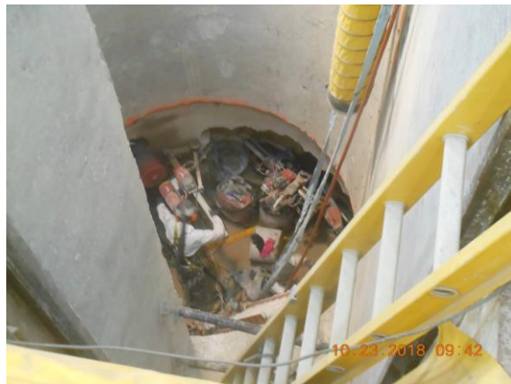
圖六、Mark F反應器下方地下窖的除役工作觀摩
