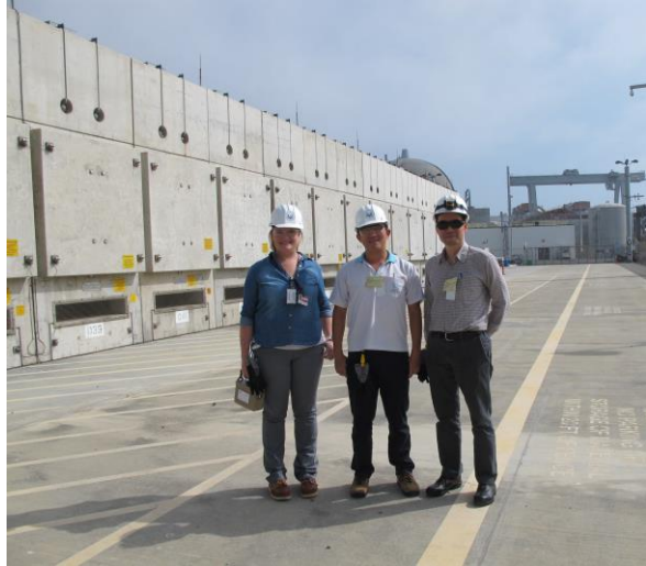
圖一、SONGS地表水平放置式乾式貯存設施(AREVA公司設計製造)
