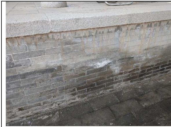
採用傳統材料及工法修復磚牆
