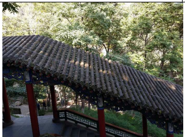
在屋簷上裝設避雷裝置
