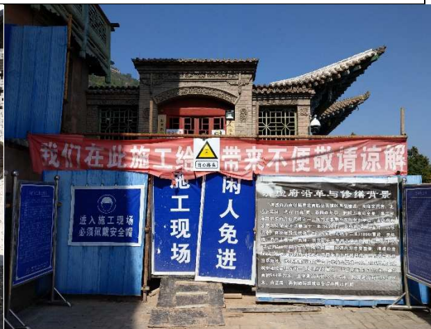
參觀修復現場
