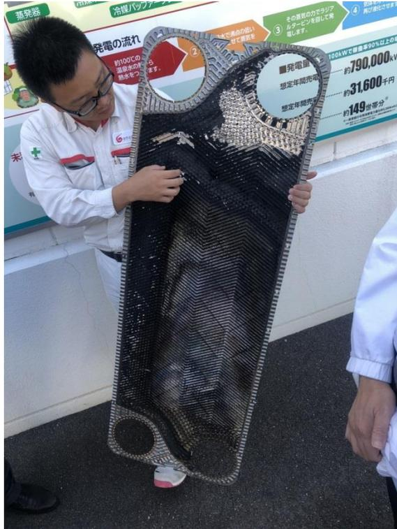
圖 25 小浜温泉發電所鈦合金熱交換板結垢拆下清洗
