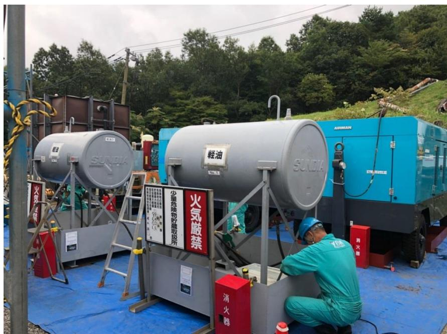
圖 4 兩台空壓機及其油線場地約 10mX10m
