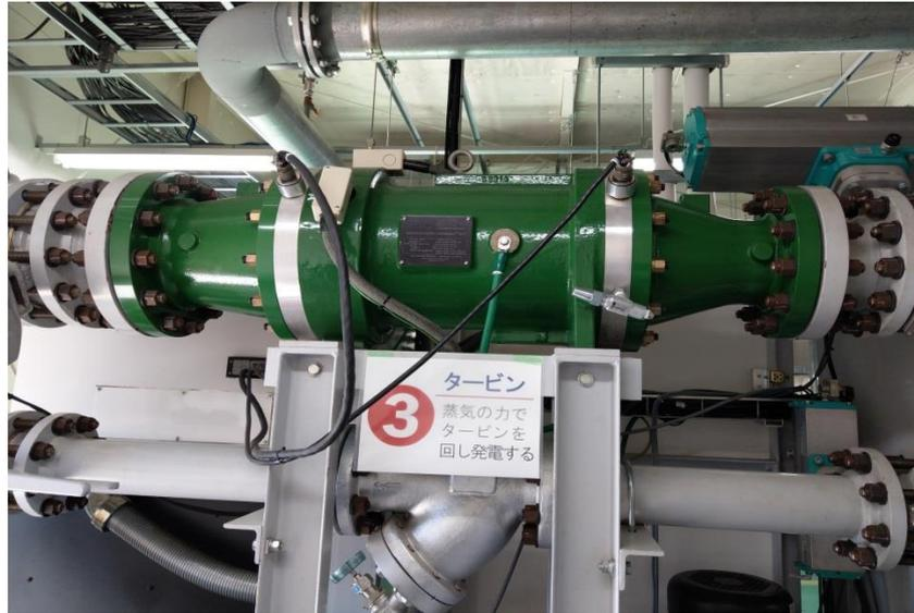
圖 22 小浜温泉發電所整合式汽輪發電機
