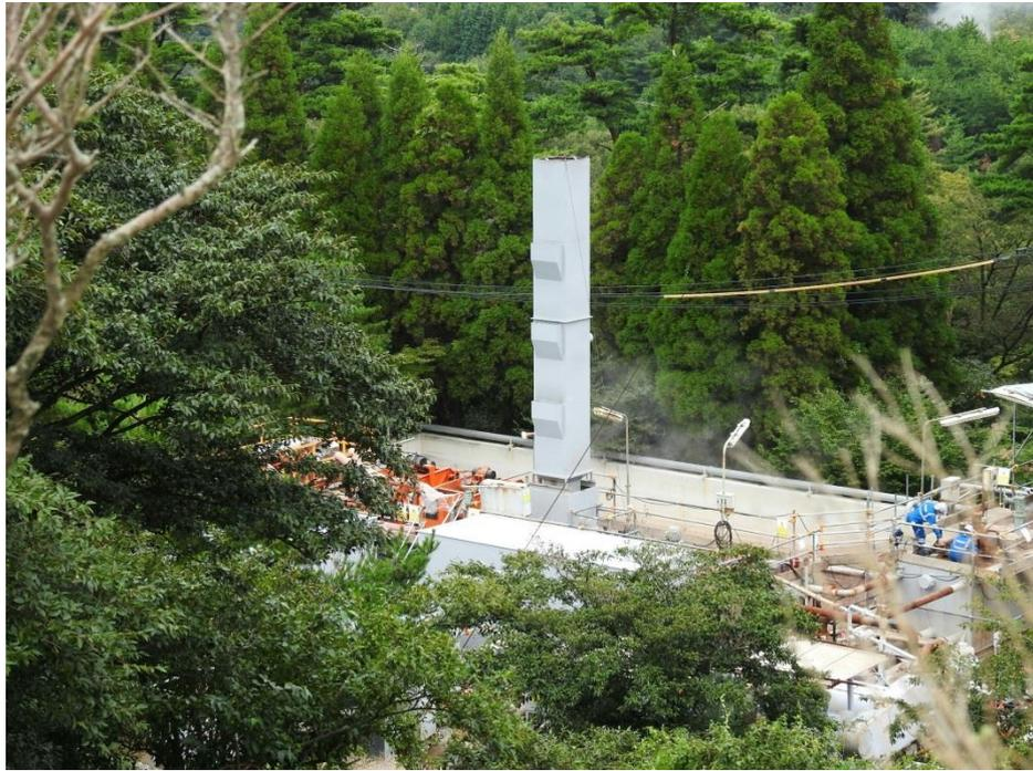
圖 11 泥漿冷卻及除氣塔
