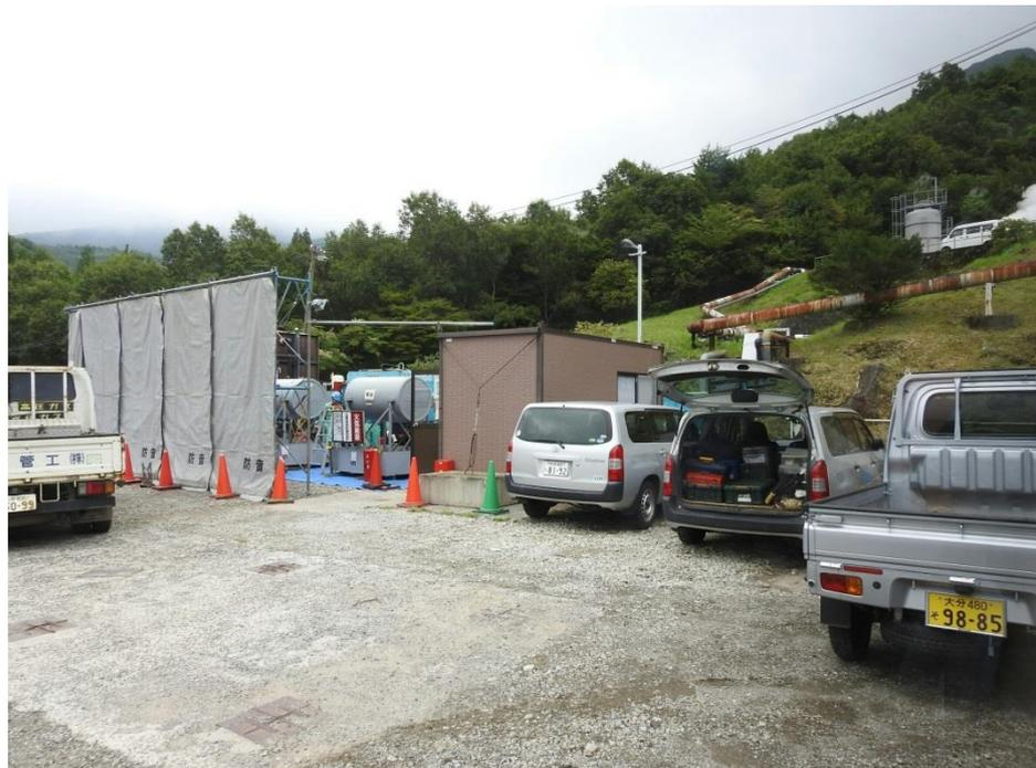
圖 10 噪音源使用隔音布隔離
