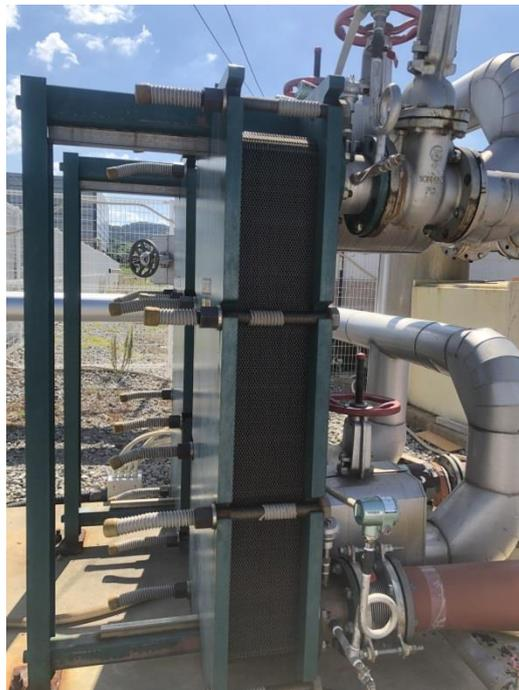
圖 24 小浜溫泉發電所鈦合金熱交換板組
