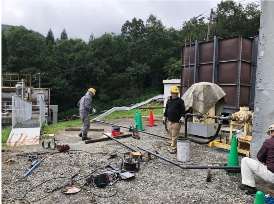
圖 5 空氣經昇壓後由 2 吋鋼管輸送到鑽井管串內
