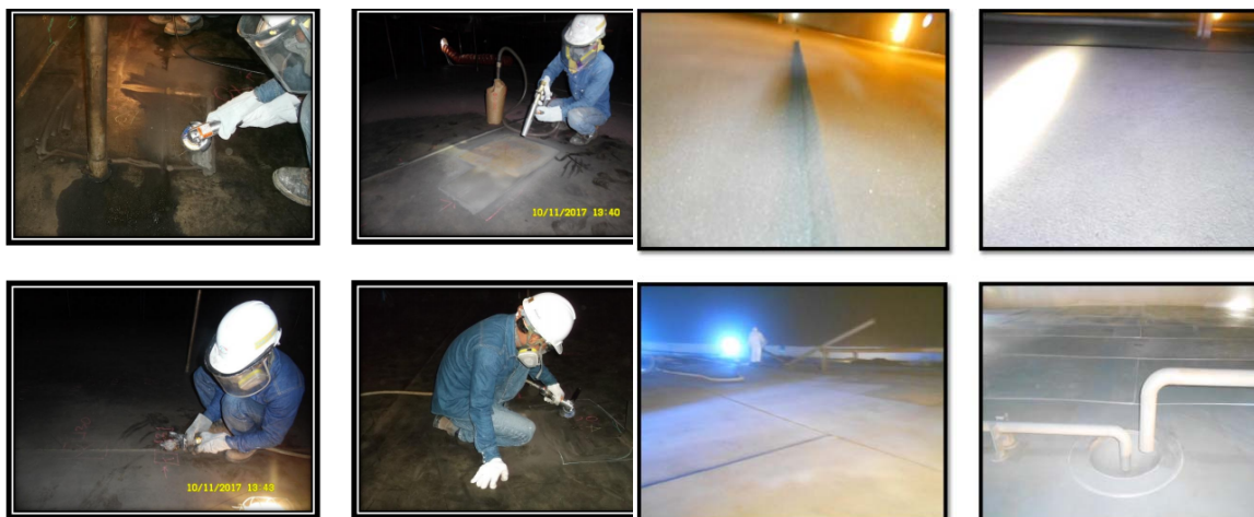
局部區域表面處理
