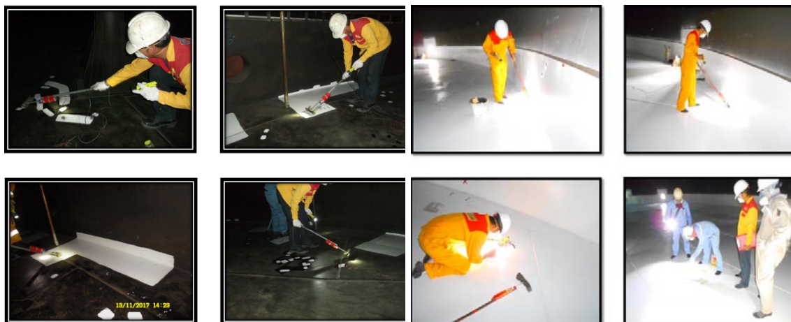
完成塗裝後之漏電測試
