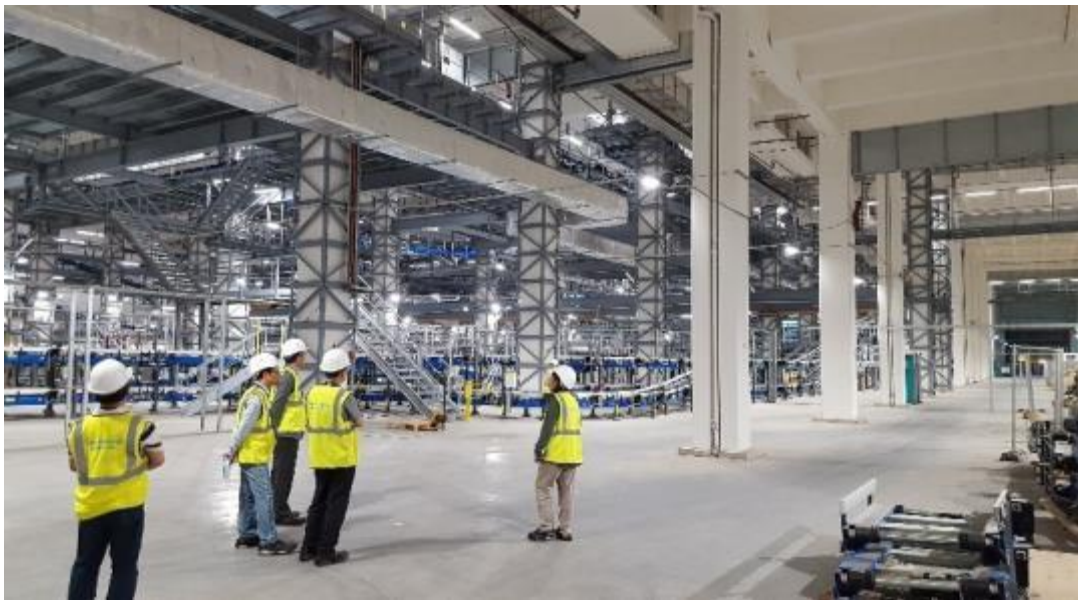
圖 30 新建之 BHS 系統(2)
