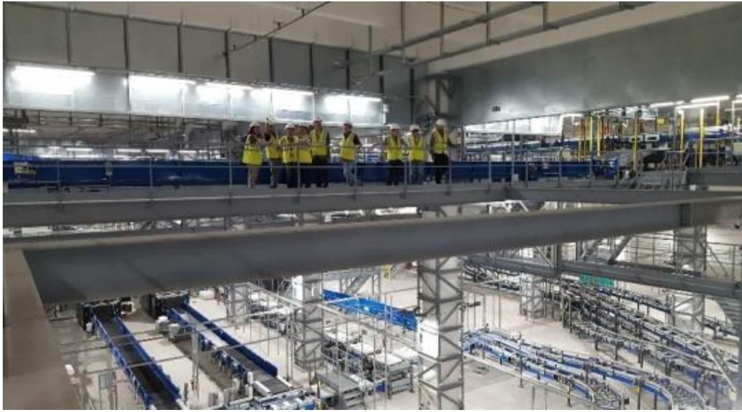
圖 29 新建之 BHS 系統(1)
