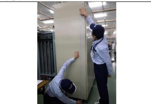
Photo 25 : 使用量尺測量機架本體的高度
