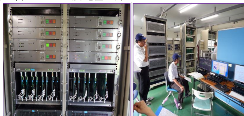
圖 3-4 各處理單元 AC/DC 出力電壓量測
