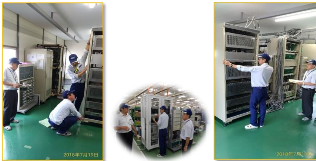
圖 3-3 號誌電子聯鎖設備尺寸量測作業
