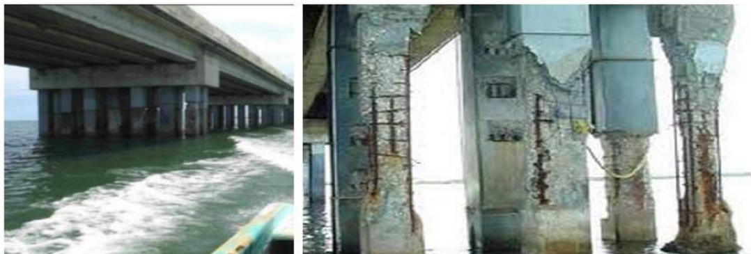
圖 3-50 La Unidad 舊橋腐蝕情形
