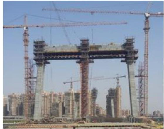
圖 3- 33 橋塔橫斷面及自爬升式模板
