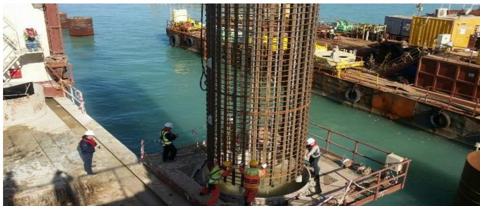
圖 3- 42 安裝鋼筋籠
