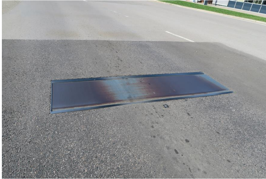
圖 3-8 厄勒海峽大橋動態減速系統未啟動現場情形
