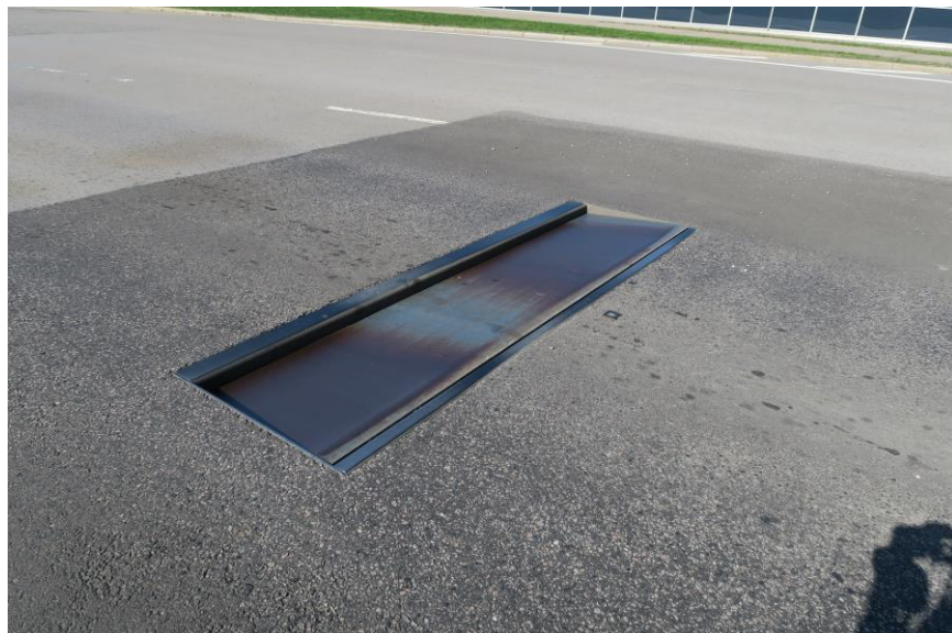
圖 3-9 厄勒海峽大橋動態減速系統啟動現場情形
